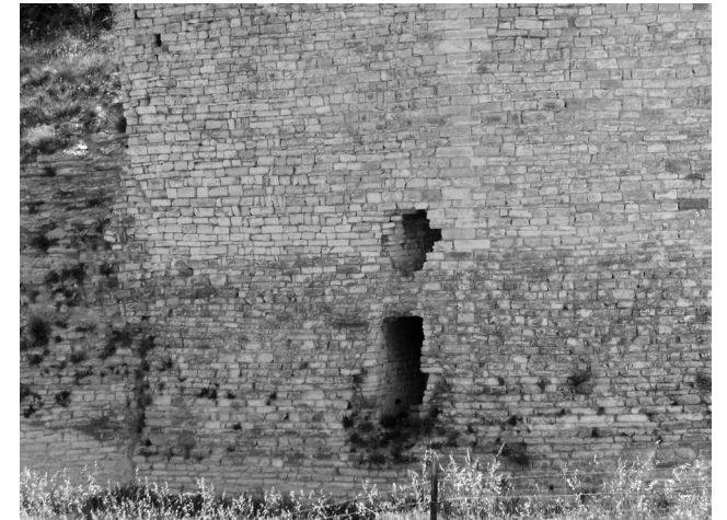
Figura 37. Ruederi del lato ovest della fortificazione
