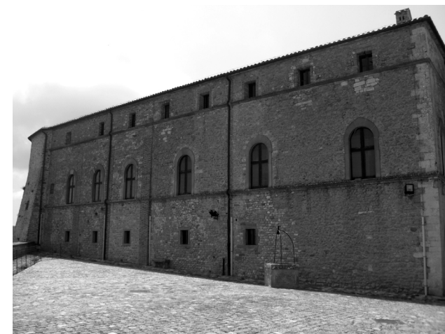
Figura 32. Francesco di Giorgio Martini, Rocca di San Leo, vista del palazzo dalla corte nord.
