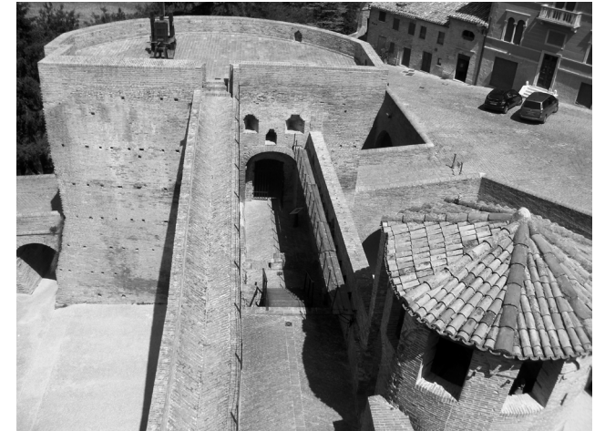
Figura 28. Particolare del torrione semi-ovale d'accesso
