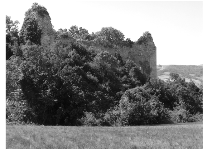
Figura 36. Ruederi del lato ovest della fortificazione
