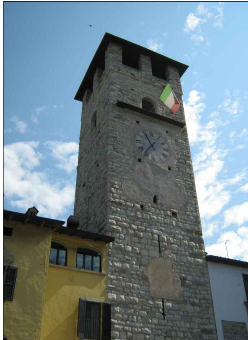
Figura 30 - Torre del Vescovo (o Torre Grande).
