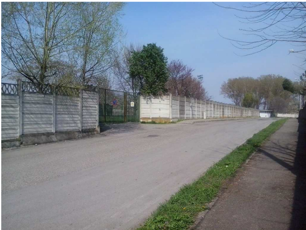
Figura 3-4 – L'avvicinamento da Via Madonna. Vista della recinzione (lato sud)
