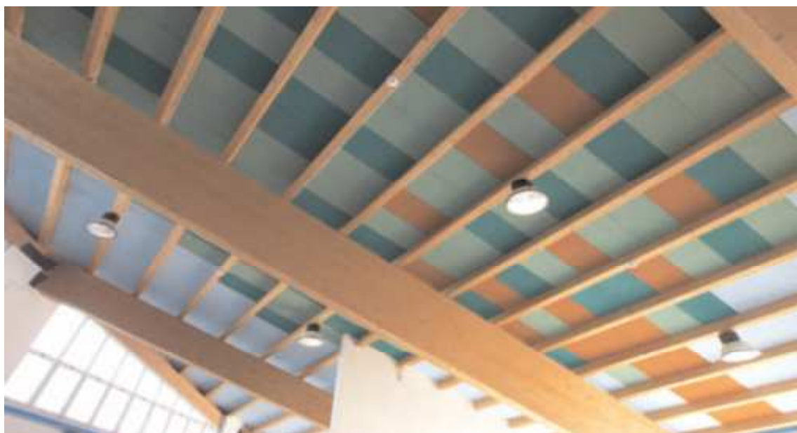
Figura 4-31 - Esempio di pannelli posizionati tra le travi
