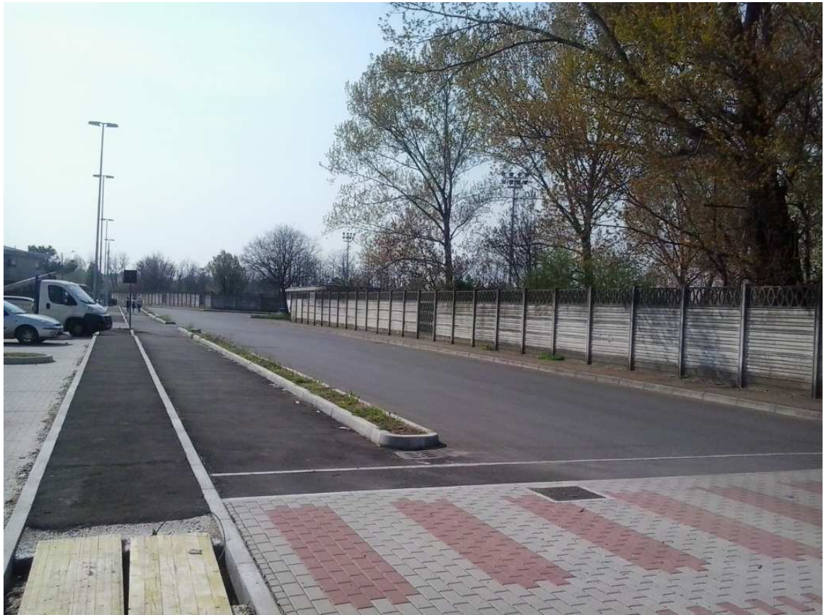
Figura 3-7 – Vista del fronte su Via Madonna (lato sud)
