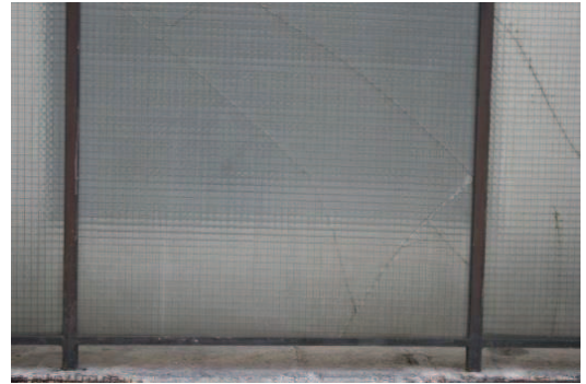
Figura 5 Parapetto balconi in vetro e ferro, autore tesi
