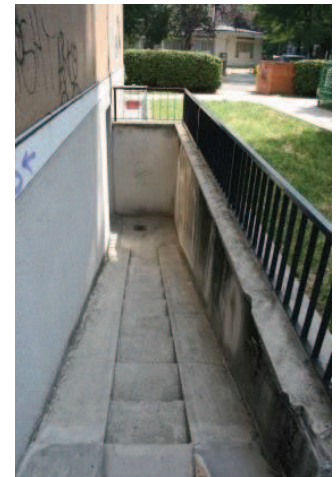
Figura 7 Scala esterna , autore tesi
