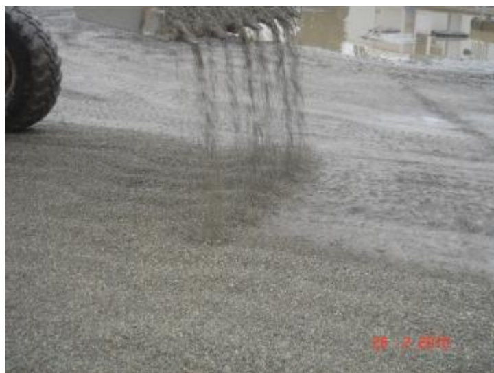
Figura 5-13 Stesura materiale inerte in corrispondenza delle uscite del cantiere
