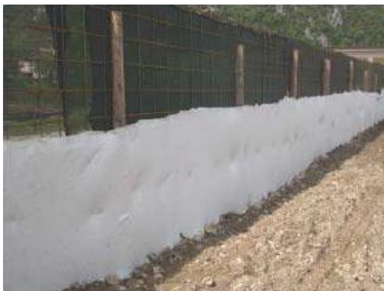
Figura 5-7 Recinzione perimetrale di cantiere protetta alla base da tessuto non tessuto
