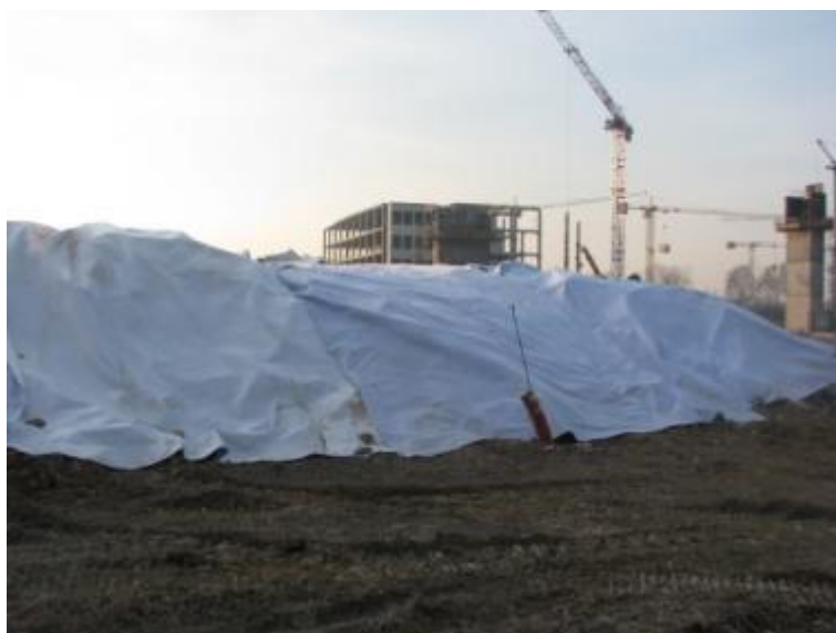
Figura 5-8 Cumuli di terra di riporto ricoperti con teli di tessuto non tessuto
