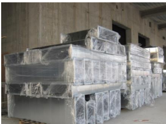
Figura 5-36: Sigillatura singola di ogni canale e stoccaggio al coperto
