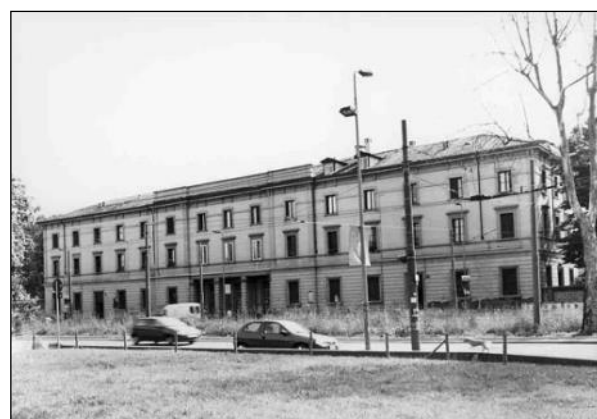
Figura 1-51 Stato di fatto dell'area
