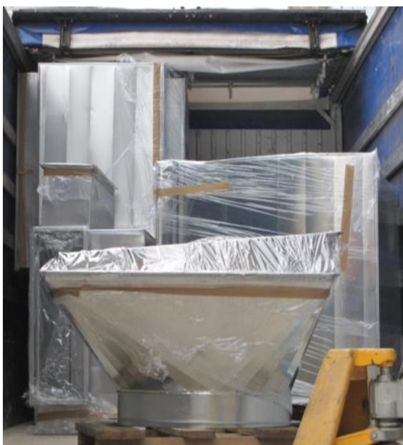
Figura 5-35: Trasporto su camion coperto degli elementi sigillati
