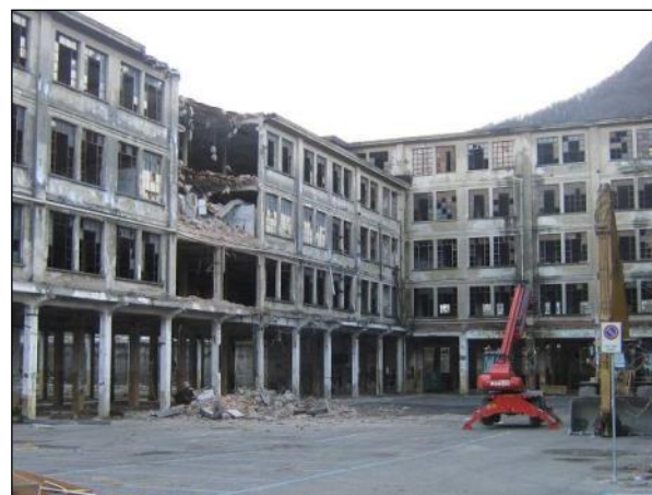
Figura 1-68 Visuale del sito di progetto durante la fase di demolizione
