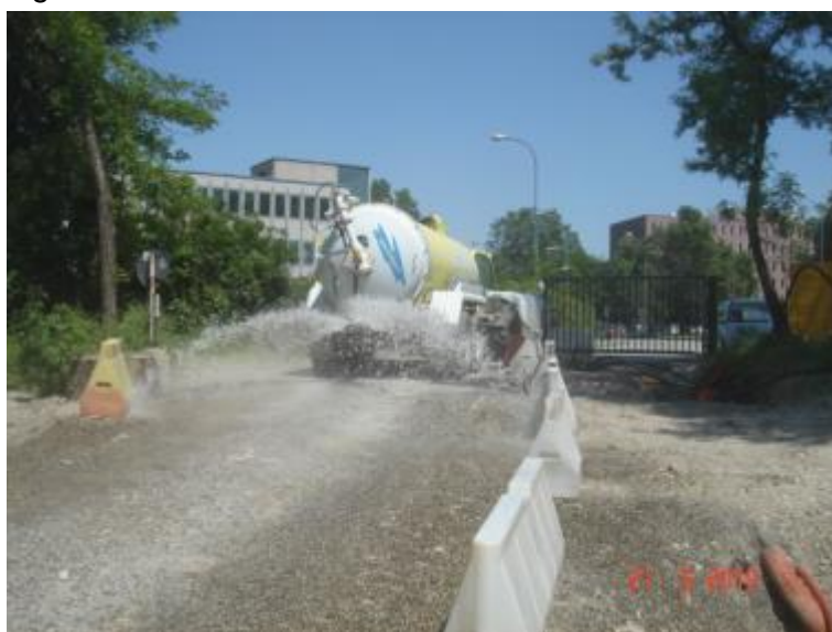
Figura 5-10 Trattore con cisterna per irrigazione delle strade di cantiere
