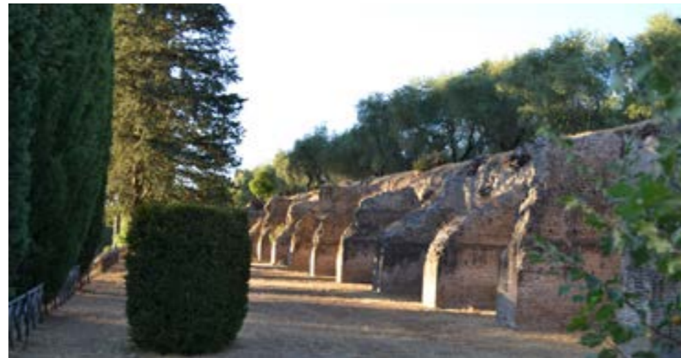
FIG 34_Vista delle sostruzioni alla base dell'Altura
