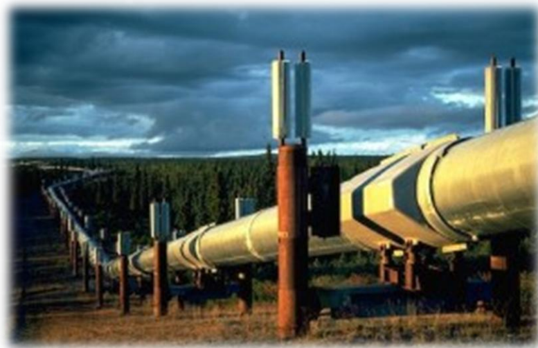
Figura 2.7 - Particolare dell'oleodotto Trans - Alaska Pipeline System
