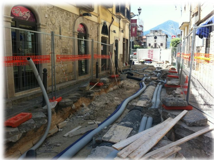
Figura 1 - Interruzione della viabilità in corrispondenza di un cantiere stradale
