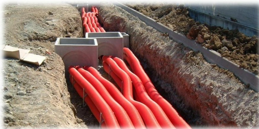
Figura 2.4 - Tubazioni per cavi elettrici in posa sotterranea
