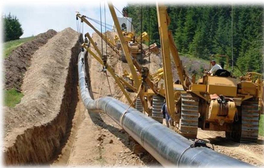
Figura 2.5 – Operazione di posa di un gasdotto
