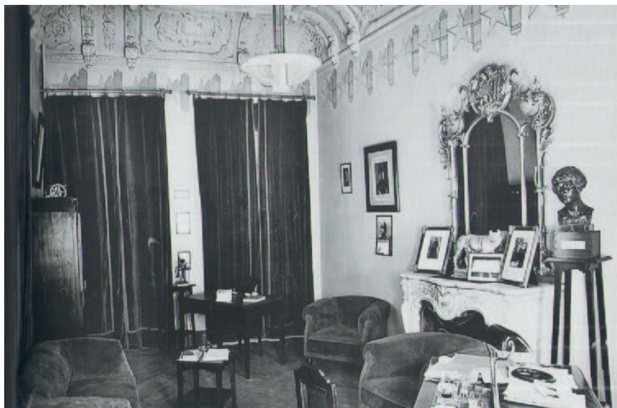
a. Fotografia storica dell'Ufficio del Fascio della Casa d'Italia, 1932; 23.5x18 cm, Archivi Aldo Campaner
