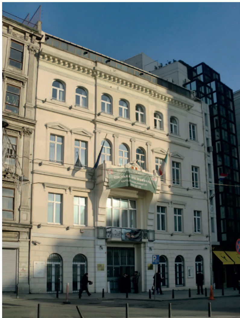
Fotografia della facciata della Casa d'Italia
