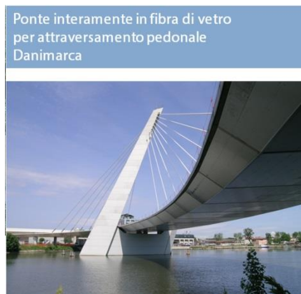
Figura 1.8: Ponte pedonale in fibra di vetro, Danimarca
