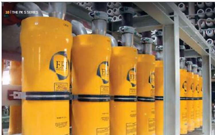
Figura 4.39. Unità ERI disposte in parallelo (ERI product catalog).
