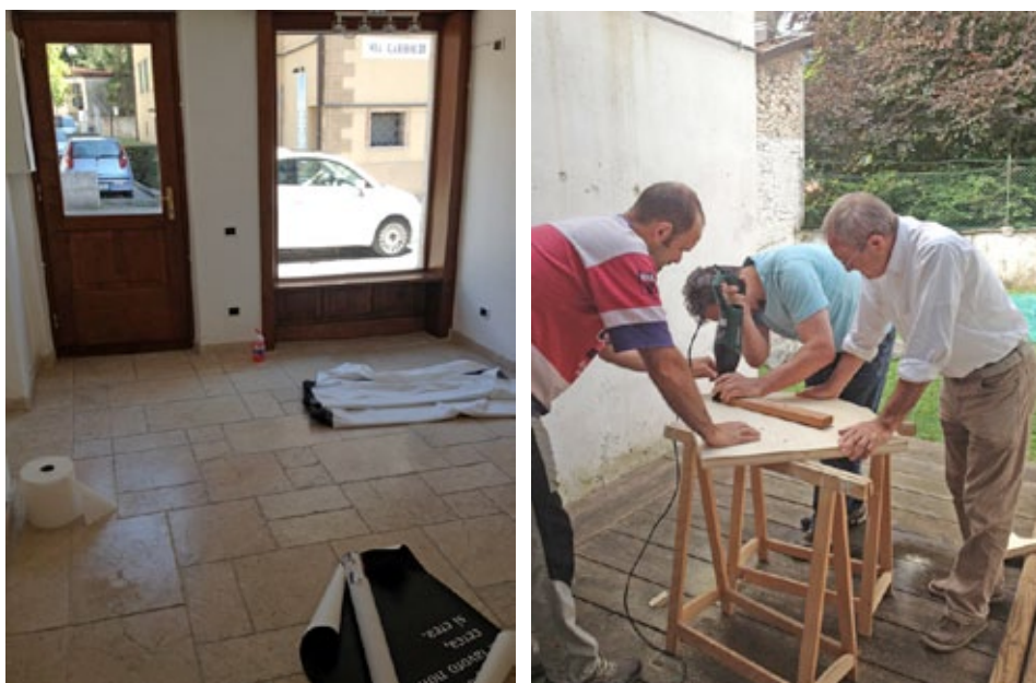
Fig. 102 Lavori per l'allestimento della mostra e della vetrina per l'esposizione
