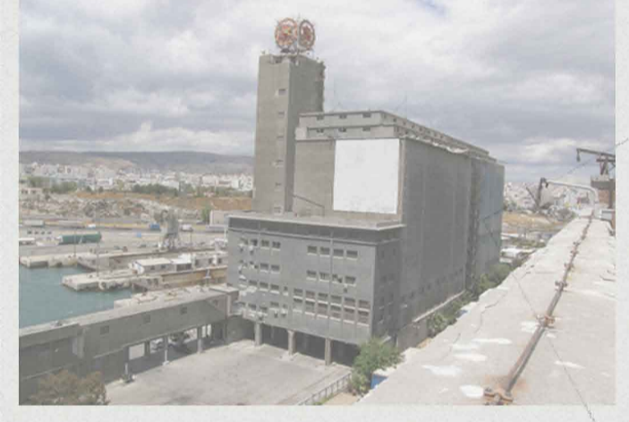
EDIFICIO TRASPORTATORE_PILONI_VISTA NORD-EST
