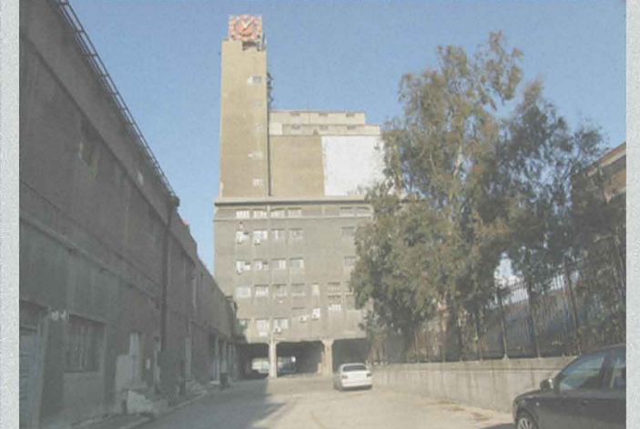
EDIFICIO TRASPORTATORE_PILONI_VISTA NORD-EST
