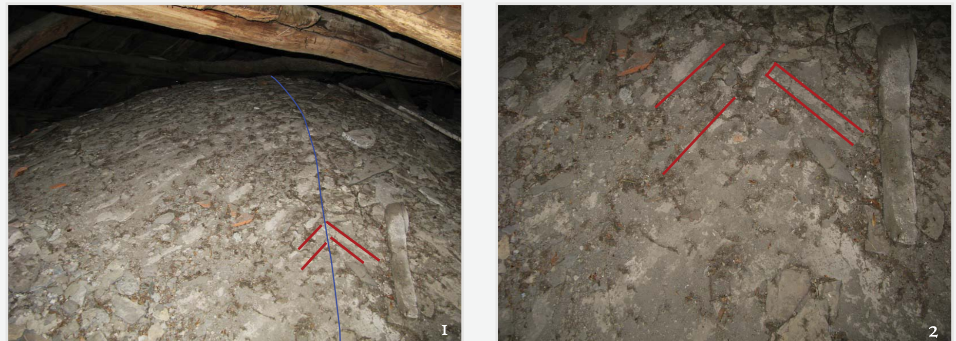
IMMAGINI: 1. Estradosso della volta centrale: in blu la linea di diagonale, in rosso disposizione dei mattoni; 2. Dettaglio dell'estradosso: in rosso evidenziata la disposizione dei mattoni, a spina pesce.
