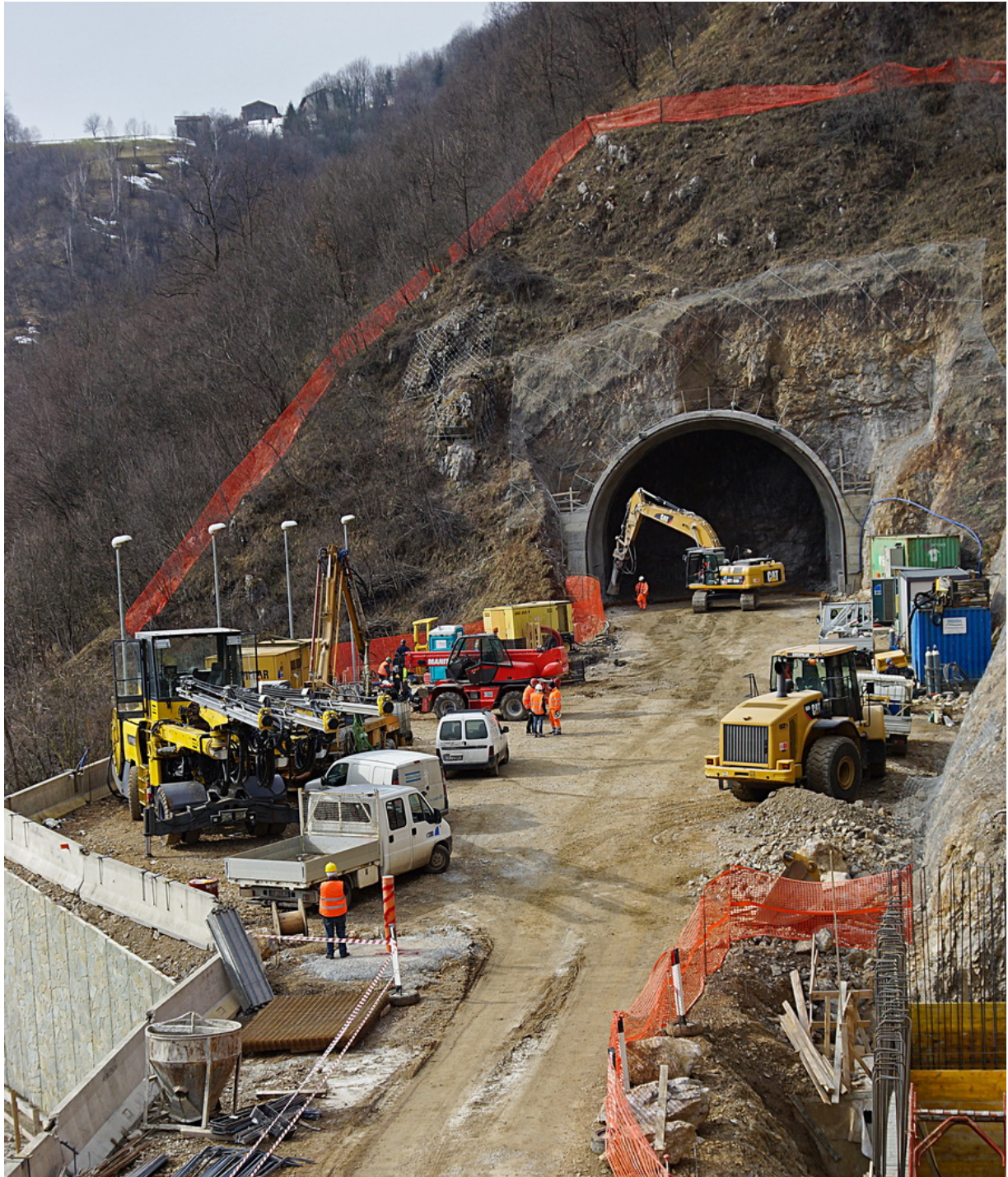
Figura 3-1 Esempio di galleria naturale, il tunnel si inserisce direttamente nella montagna.
