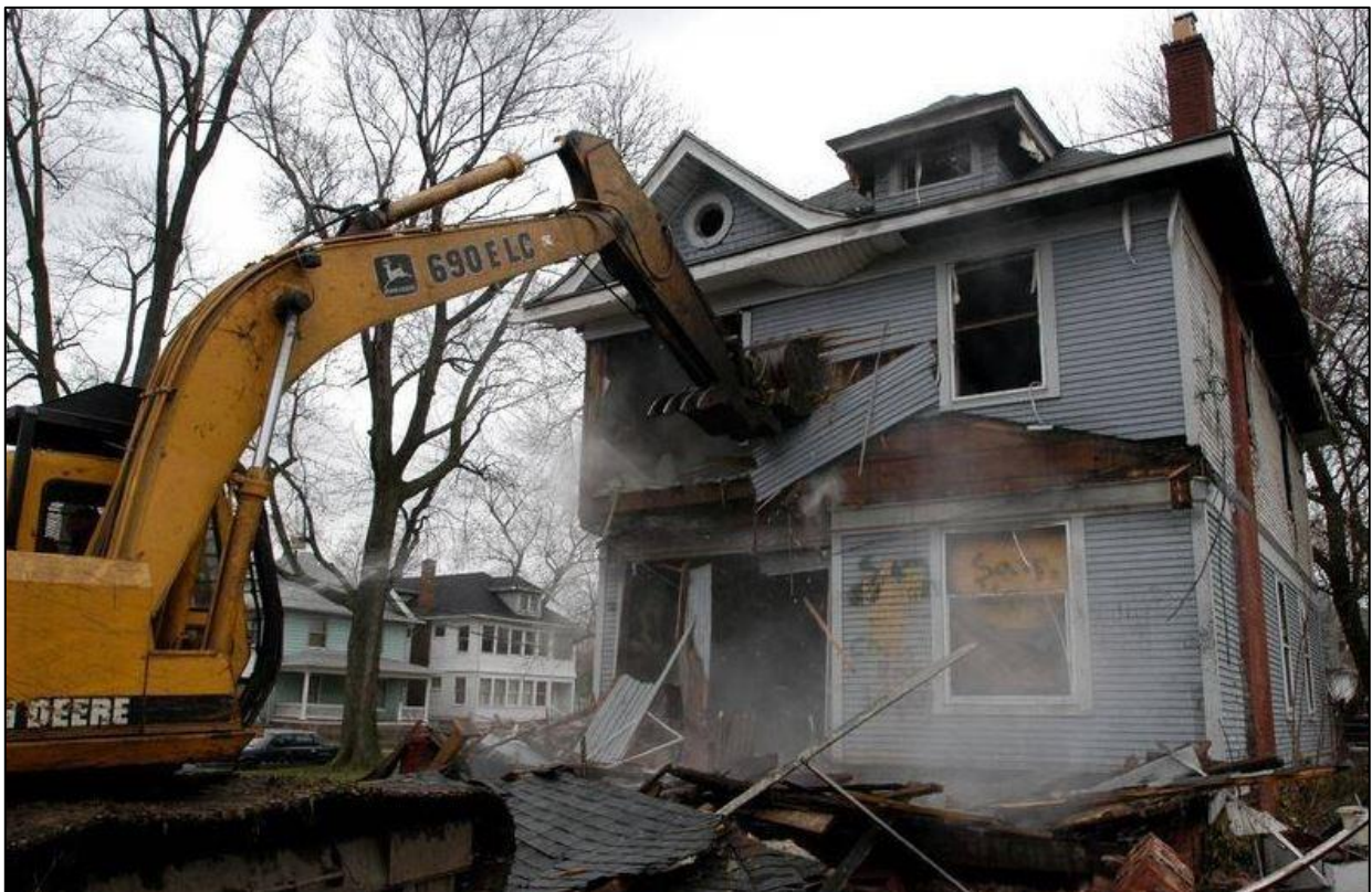
Figura 25 - Demolizione di un edificio abbandonato in Warren Street nella città di Toledo, Ohio 39 .
