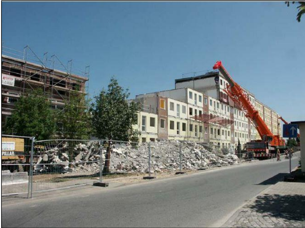
Figura 50 - Demolizione di un'abitazione a Dresda 110 .
