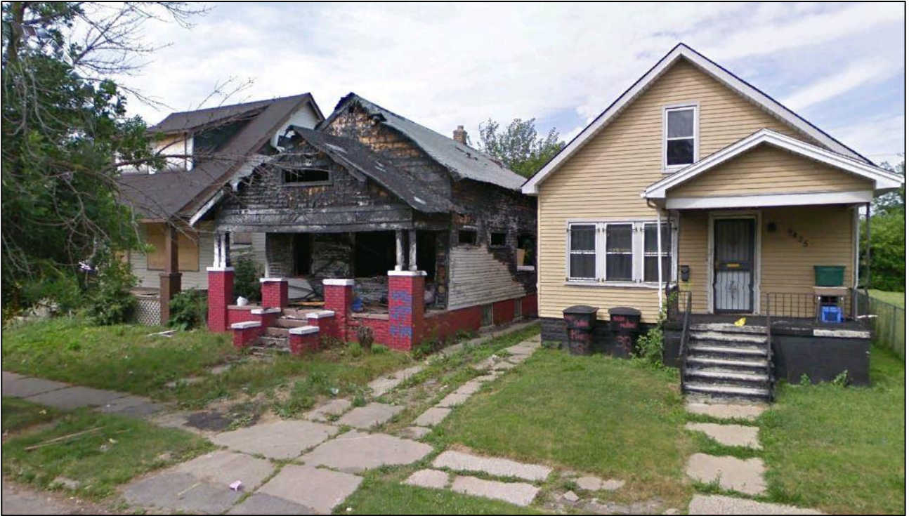
Figura 9 - Casa distrutta da un incendio in Prairie Street, Detroit.
