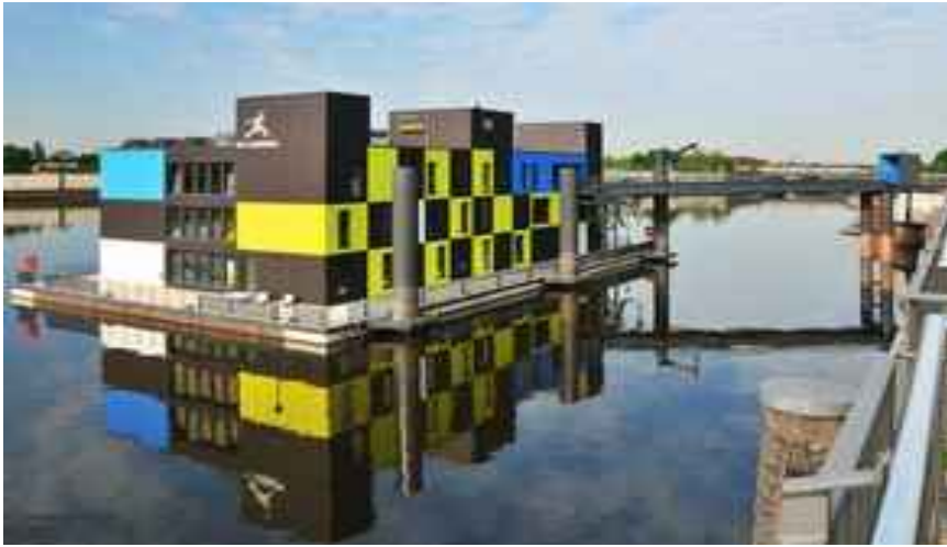
vista dal lato del waterfront
