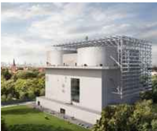
Energy bunker dopo l'intervento
