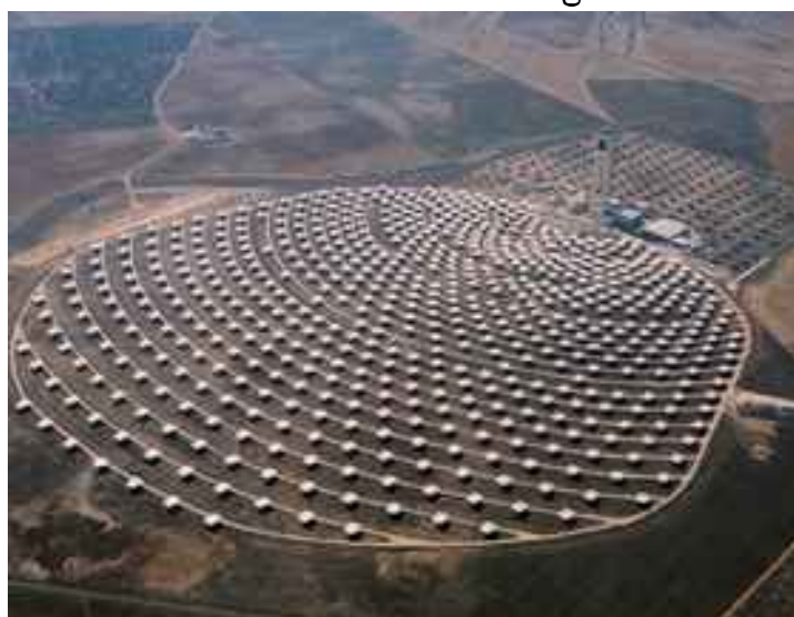
Vista aerea impianto PS-10
