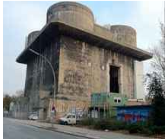
Il bunker antiaereo prima dell'intervento
