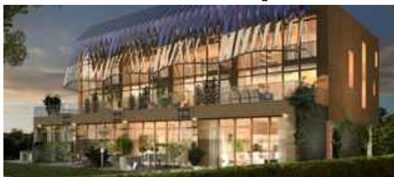
la parete a sud con le strisce tessili fotovoltaiche
