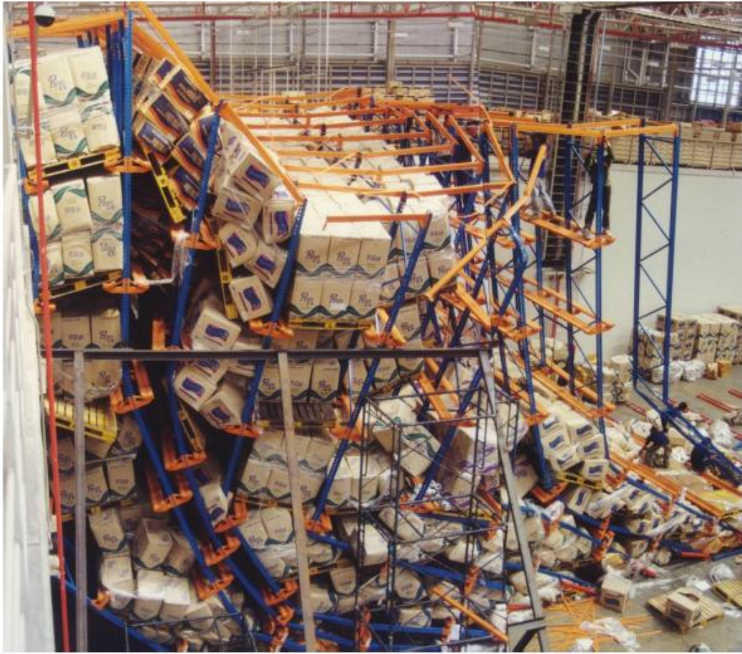
Figura 2.5.2 Collasso di una scaffalatura industriale
