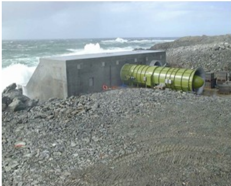
Figura 5.15. Vista d'insieme dell'impianto Limpet. Si noti in verde il condotto della turbina
