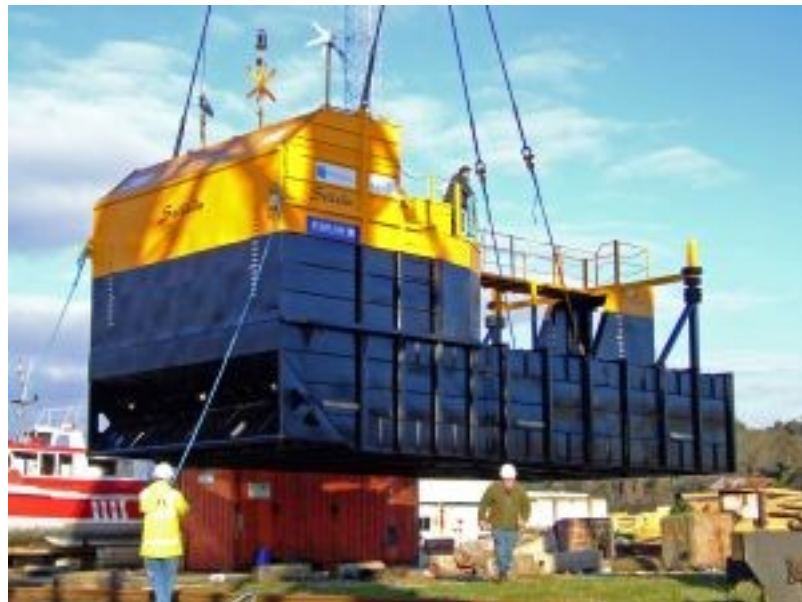
Figura 4.9. OE Buoy nella fase di messa in opera
