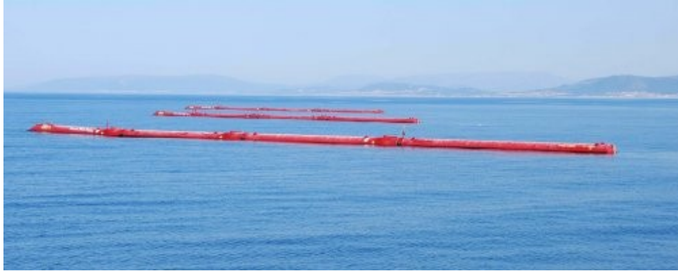
Figura 5.17. Vista dei macchinari Pelamis P1 installati ad Agucadoura
