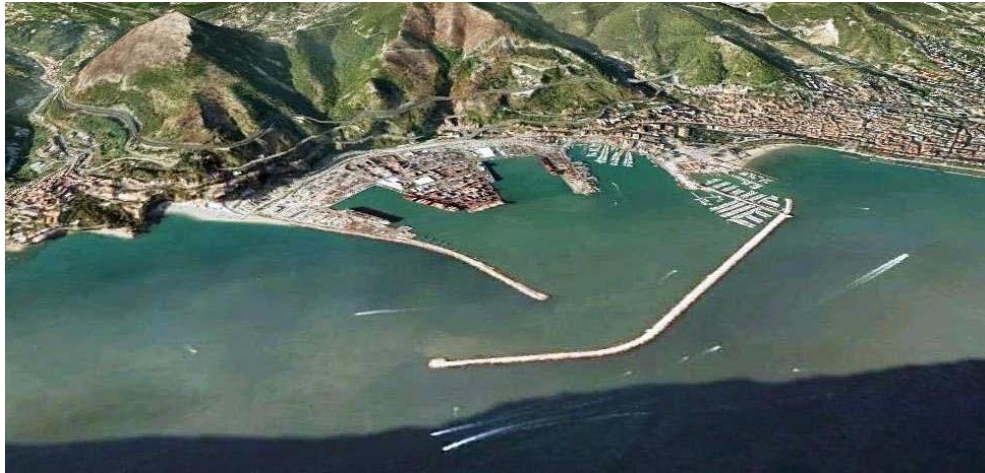
Figura 5.26. Vista aerea del porto di Salerno. La nuova barriera frangiflutti verrà costruita ad estensione di quella già presente, per una lunghezza di 200m.
