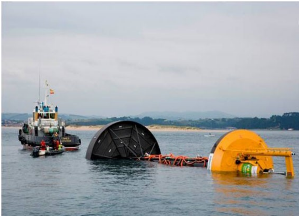
Figura 4.19. Installazione del PowerBuoy nel sito di Santona
