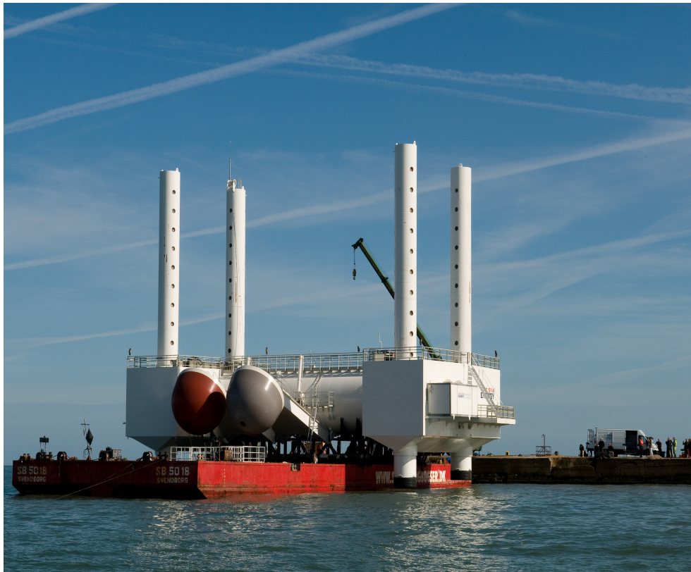
Figura 4.16. Centro di prova del WaveStar al DanWEC in fase di costruzione
