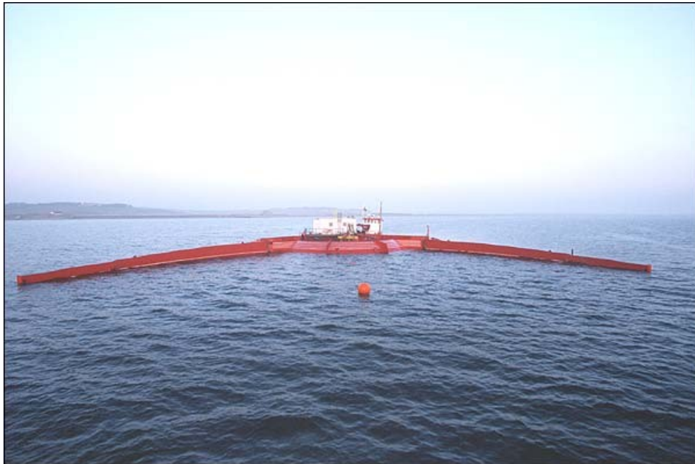
Figura 4.24 Vista del Wave Dragon in mare aperto. Al centro si ha il bacino di stoccaggio dell'acqua. Fonte Wave Dragon
