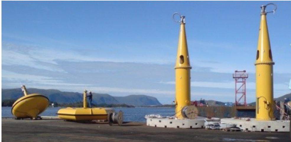
Figura 5.5. Installazione dei dispositivi a Lysekil
