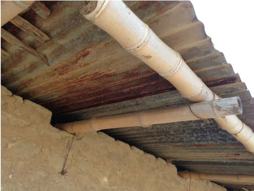
Figura 4.22 Particolare del tetto: le canne sono collegate tra loro con pochi giri di fil di ferro. Sono inoltre in evidenza gli appoggi sul muro, le travi del tetto sono fissate con del filo che passa da un foro attraverso la parete.
