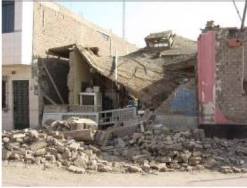
Figura 5.13 Ribaltamento fuori piano delle facciate e collassi di interi edifici.
