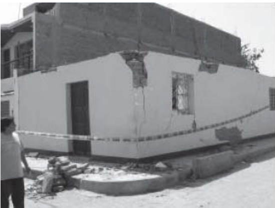
Figura 5.14 Fratture diagonali in case di Adobe agli angoli delle abitazioni.
