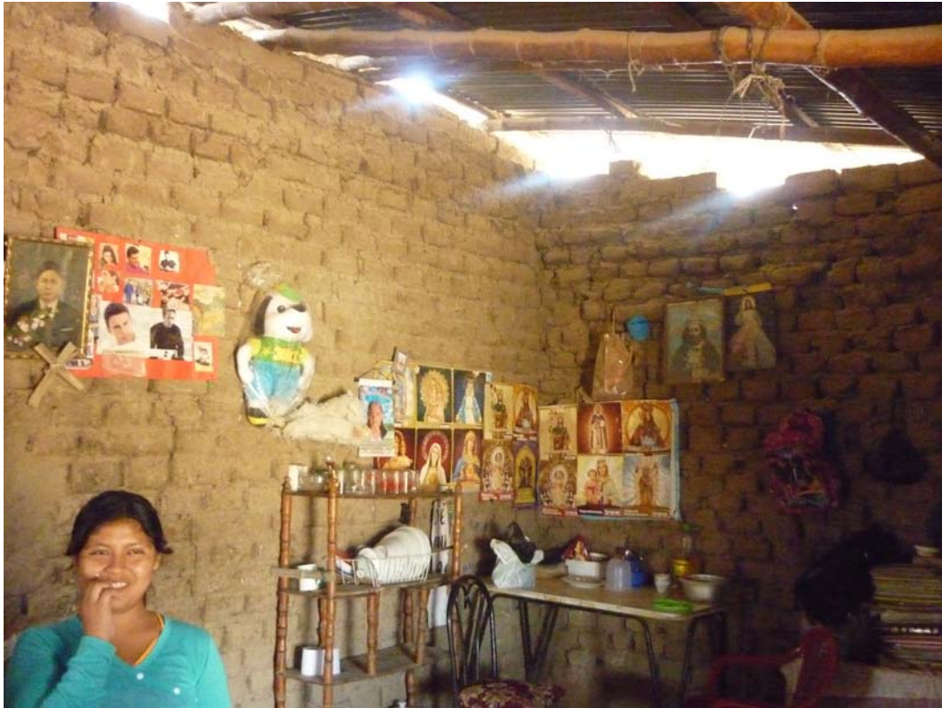
Figura 4.15 Interno di un'abitazione: all'angolo è evidente la scarsa attenzione nella disposizione efficace dei mattoni, che garantisce un corretto ammorsamento dei muri.
