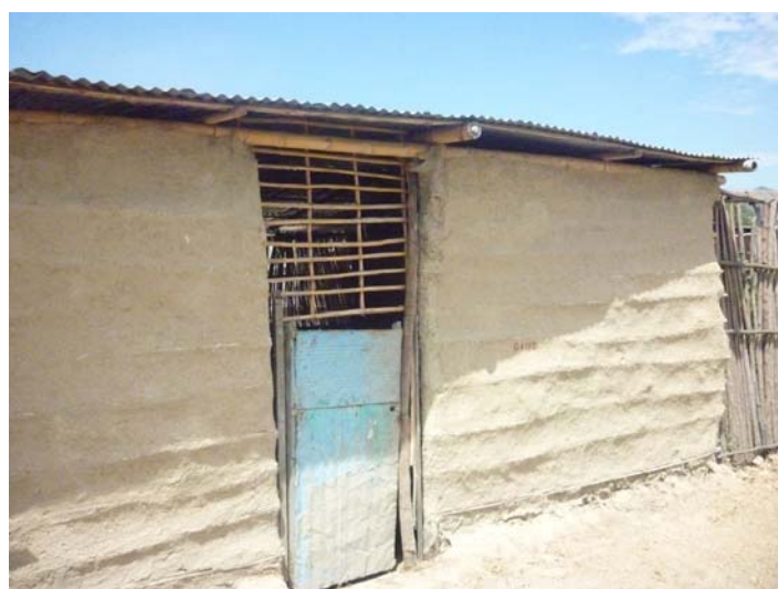
Figura 2.29 Abitazione in terra e legno (simil Quincha) a Piura la Vieja.
