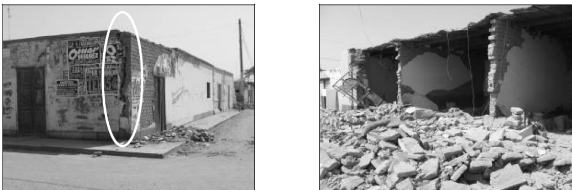
Figura 5.7 Fessure verticali tra muri ortogonali e ribaltamento di muri di facciata causati dal terremoto di Pisco (Perù), 2007.
