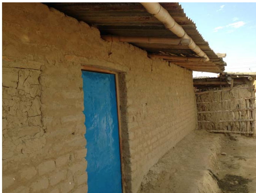
Figura 4.21 Tetto sulla strada per Chulucanas: canne appoggiate in scalanature sui muri (mattoni mancanti), sovrastati da una lamiera ( calamina ).
