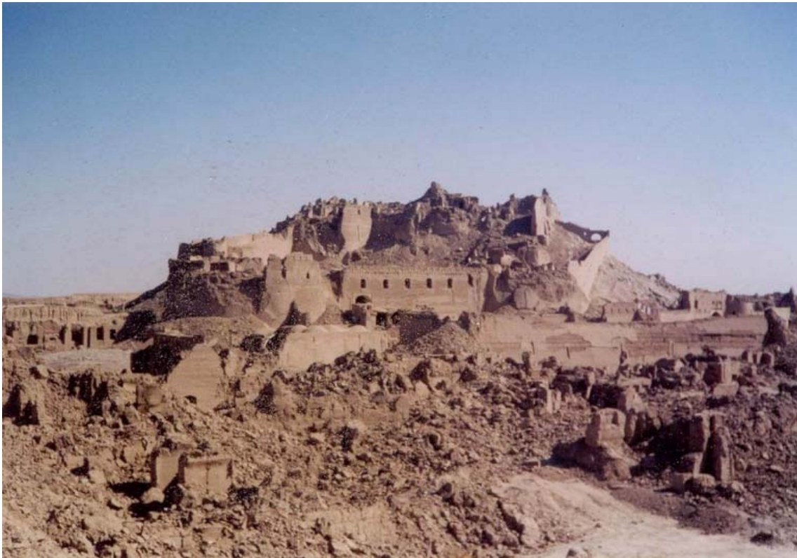
Figura 3.14 Cittadella di Bam dopo il terremoto del 2003.
