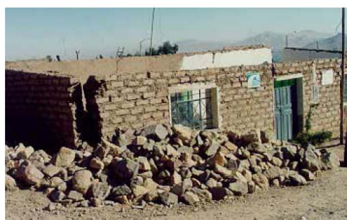
Figura 6.11 Case rinforzate e non rinforzate dopo il terremoto del 2001.
