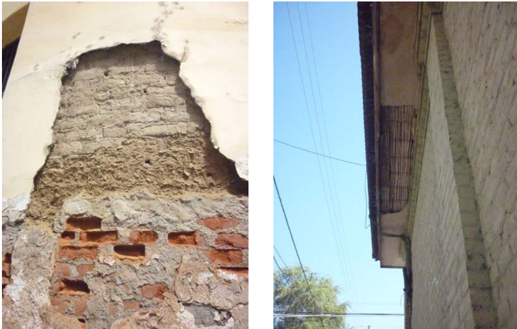
Figura 2.23 Particolari del muro di mattoni cotti e Adobe, e del tetto in caña di Guayaquil.
