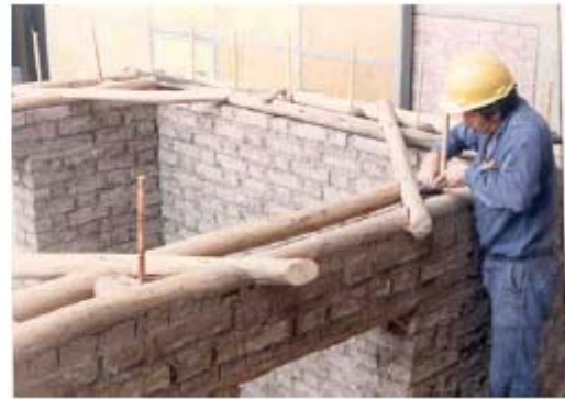
Figura 6.1 Armature interne di canna (verticali e orizzontali), successivamente ancorate alla corona in legno.
