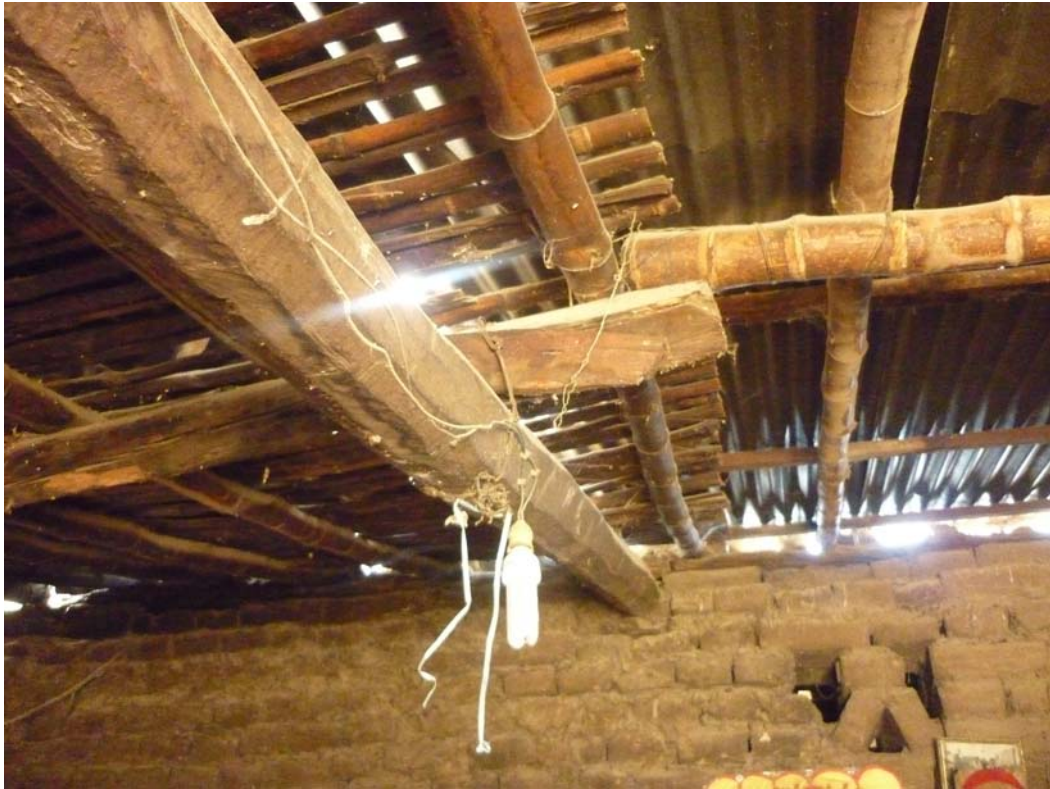
Figura 4.28 Tetto visto dall'interno di una casa di Piura la Vieja: discontinuità nel mezzo di una stanza, complicata orditura di travi (anche con canne spaccate) da cui pende l'elettricità.
