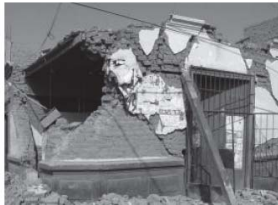
Figura 5.14 Fratture diagonali in case di Adobe agli angoli delle abitazioni.
