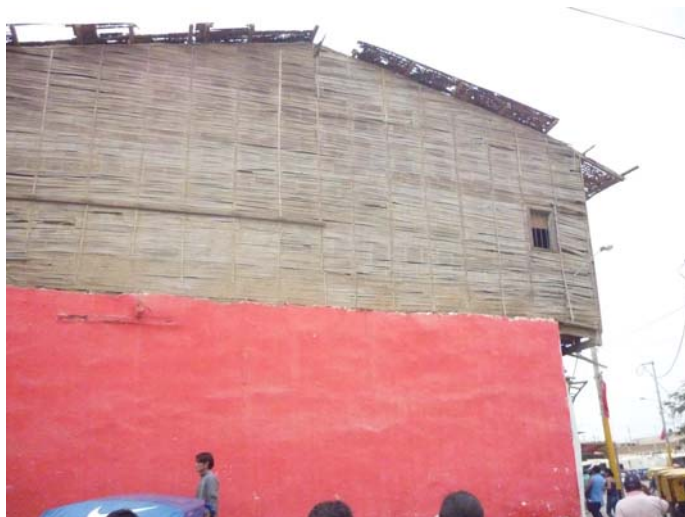
Figura 2.25 Secondo piano in caña di Guayaquil, Paita.
