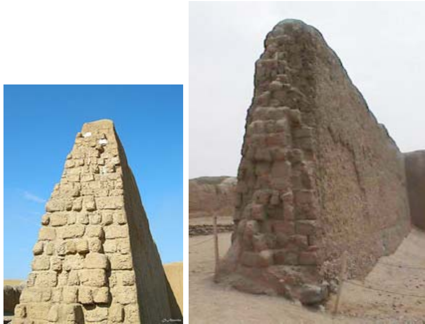
Figura 2.16 Sezione piramidale dei muri di Chan Chan.
