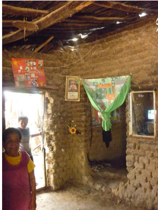
Figura 4.16 Varco che collega le uniche due stanze della casa: anche qui è evidente la disposizione quasi casuale dei mattoni nella muratura.
