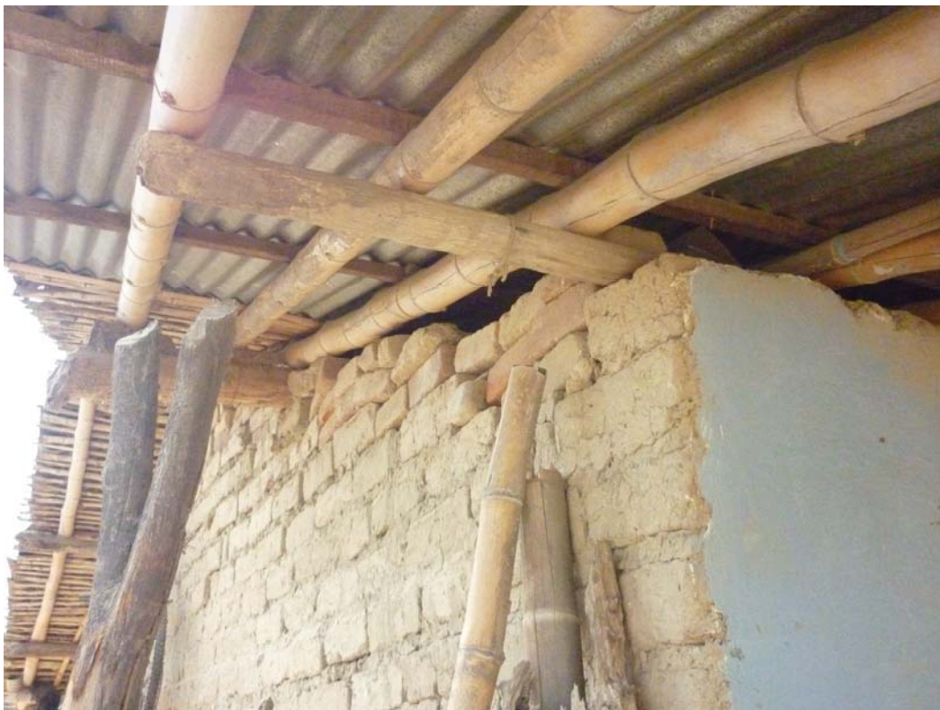
Figura 4.27 Complesso e confusionario incrocio di travi, per sorreggere la lamiera.
