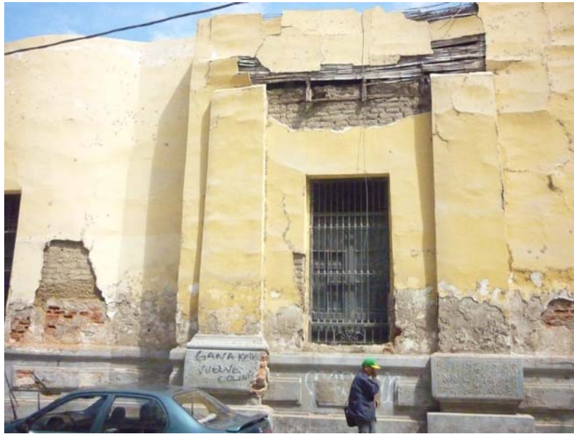
Figura 2.22 Edificio vicino Plazuela Merino: in evidenza ci sono i tre strati di tecniche costruttive differenti.
