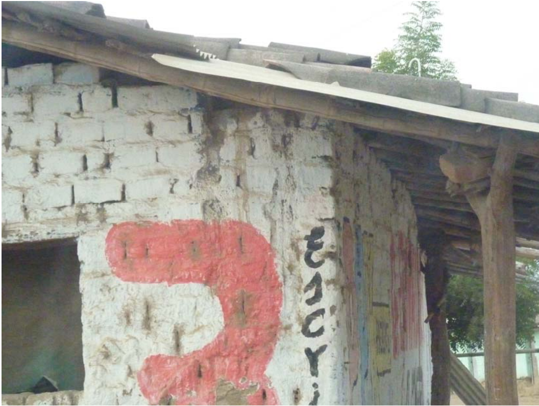
Figura 4.26 Particolare dell'appoggio delle travi del tetto: accolte da una speciale forma di pilastro e legate sommariamente con del filo.
