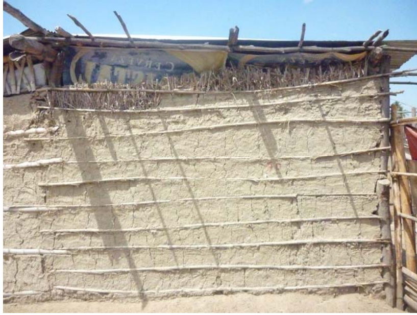
Figura 2.20 Abitazione di “simil Quincha” sulla strada da Piura moderna a Piura la Vieja.
