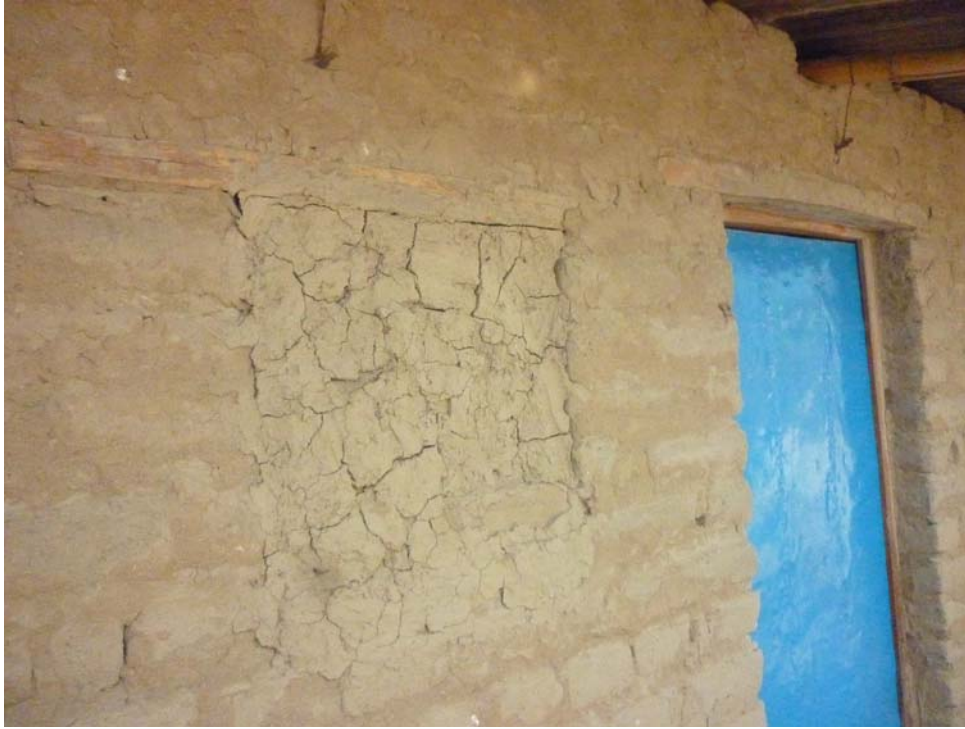
Figura 4.20 Finestra chiusa, con architrave in legno in evidenza sopra entrambe le aperture.
