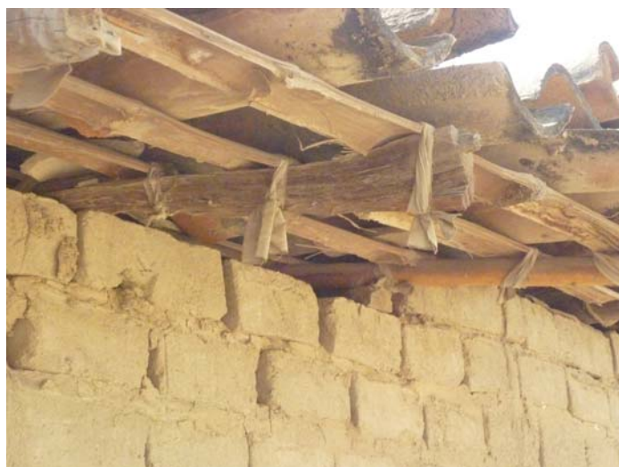
Figura 4.31 Connessioni travi di canna e copertura di canne spaccate e tegole con lacci di stoffa.
