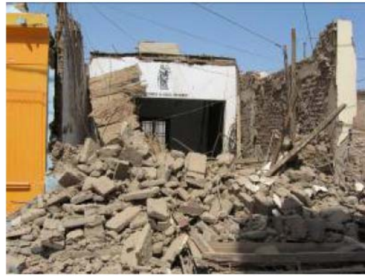
Figura 5.13 Ribaltamento fuori piano delle facciate e collassi di interi edifici.
