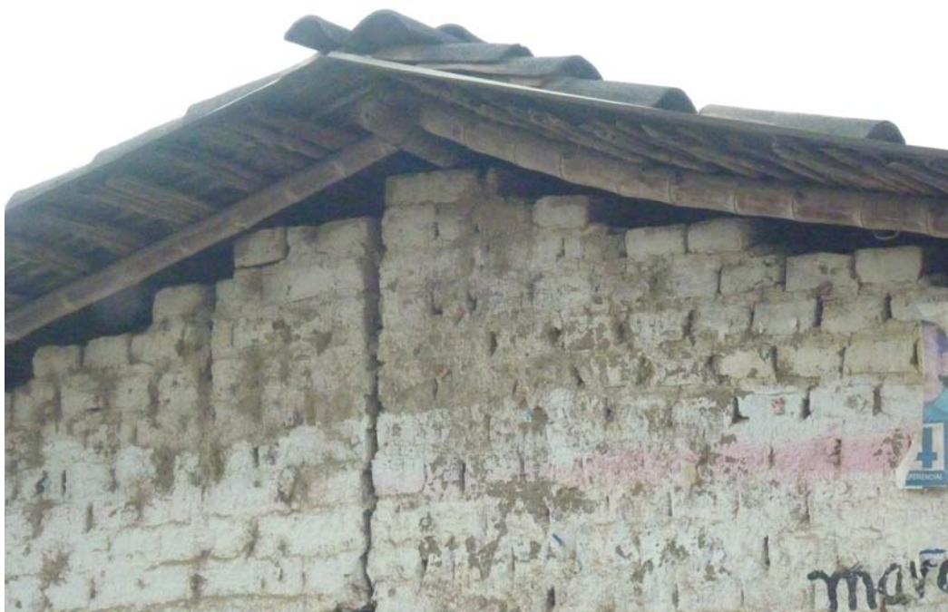
Figura 4.25 Particolare del colmo del tetto: le travi sulla muratura non sono fissate e sono appoggiate alla scalinatura della parete. Quest'ultima presenta un'evidente fessura verticale, proprio vicino al colmo.
