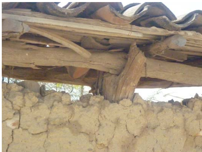
Figura 4.30 Particolare di giunto trave colonna.
