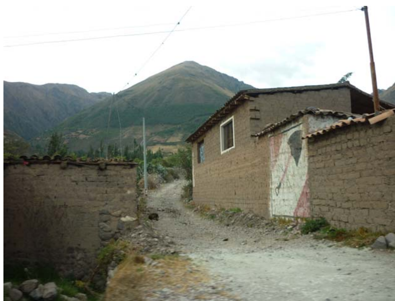
Figura 2.19 Case a due piani e a un piano di Adobe, sulla strada da Ollantaytambo a Urubamba.
