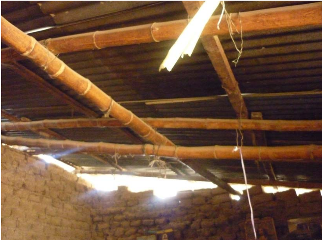
Figura 4.29 Sovrapposizione abbastanza casuale delle travi del tetto viste dall'interno.
