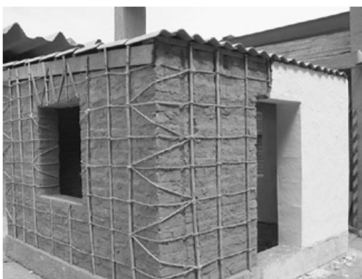
Figura 6.4 Mesh esterna di origine naturale, costituita da canne (in direzione verticale) e corde (orizzontale e diagonale).
