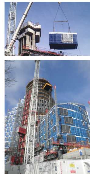
Fig. 88. Il processo di costruzione modulare della residenza per studenti Victoria Hall a Wembley, Londra. Fonte: Sito web www.modular.org del Modular Building Institute.
