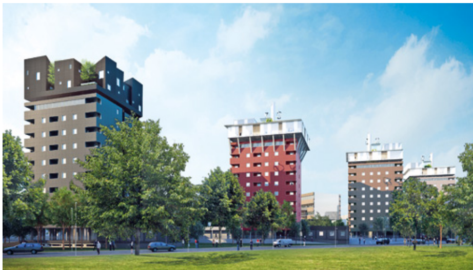
Fig. 102. Amplificazione in copertura degli alloggi pubblici del Comune di Milano con strutture in legno prefabbricate. Fonte: Il progetto di Mario Cucinella per la riqualificazione del quartiere dell'Aler a Milano. Sito web di Lignius.
