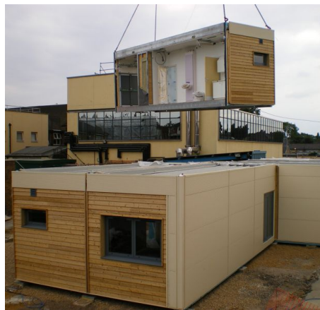
Fig. 101. Esempio di assemblaggio in cantiere di moduli prefabbricati per un'abitazione. Fonte: il sito web www.prefabbricatisulweb.it
