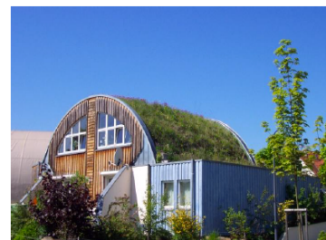
Fig. 71. Abitazione con un tetto verde in Germania. Fonte: Ressource-efficient Construction (Aprile 2011) - Eco-innovation observatory.
