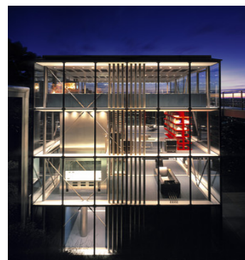
Fig. 70. Il primo edificio "triple zero", a Stuttgart in Germania nel 2000. Fonte: Sito web dell'architetto-ingegnere Werner Sobek.
