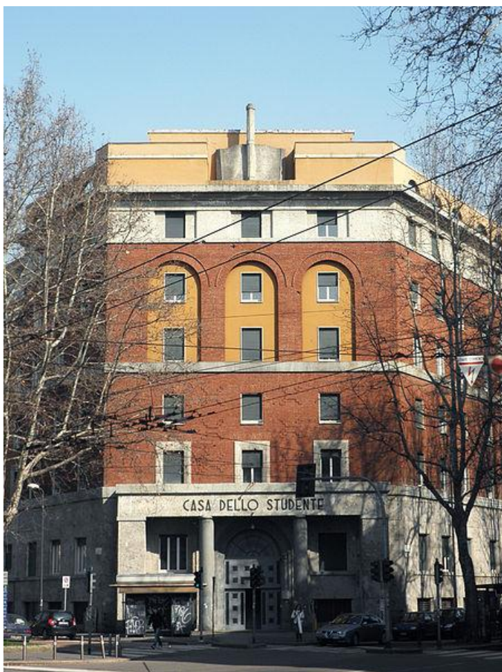
Figura 4: Vista ingresso "Casa dello Studente"
