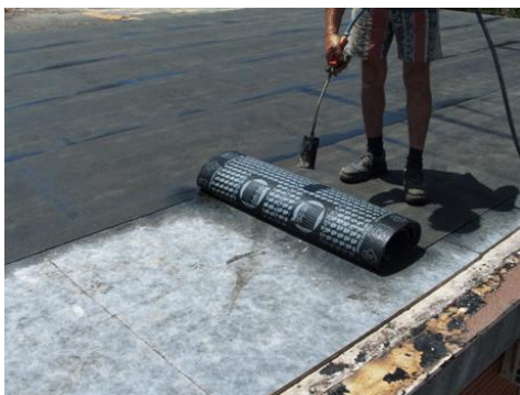
Fig. 213 Impermeabilizzazione vespaio
