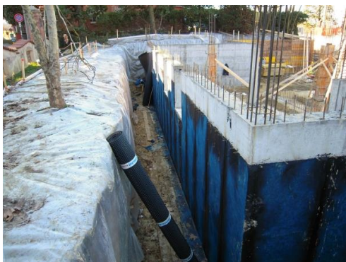
Fig. 197 Impermeabilizzazione
