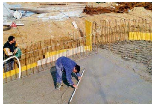
Fig. 210 Operazioni di livellamento
