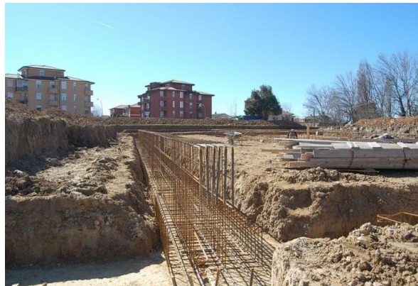
Fig. 182 Armatura trave rovescia
