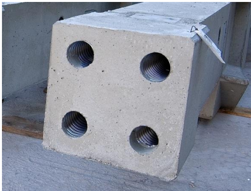
Fig. 60 Pilastrò prefabbricato, ripresa
