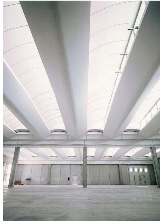
Fig. 64 Esempio copertura prefabbricata
