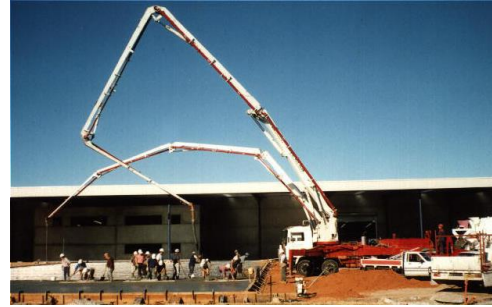
Fig. 165 Braccio autopompa
