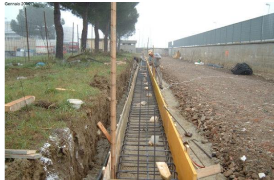
Fig. 186 Casseratura trave fondazione
