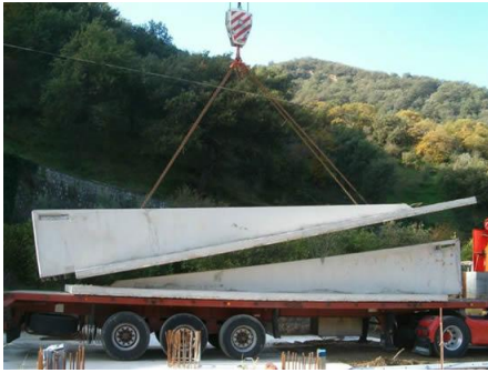
Fig. 153 Catene per la movimentazione di materiali
