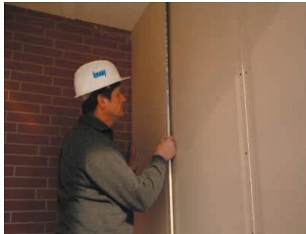
Fig. 222 Posa in opera lastre di gesso
