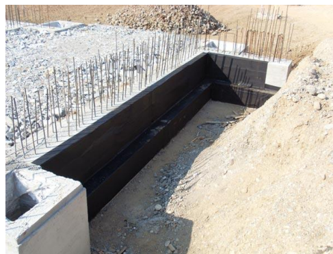
Fig. 198 Protezione fondazioni
