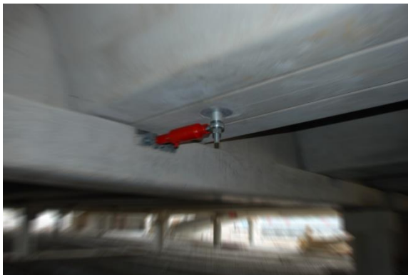
Fig. 55 Esempi di giunti antisismici
