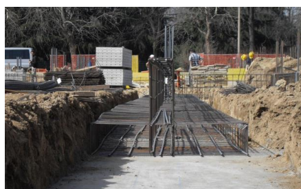
Fig. 180 Armatura trave rovescia
