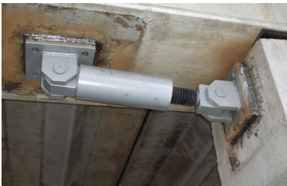
Fig. 58 Esempi di giunti antisismici
