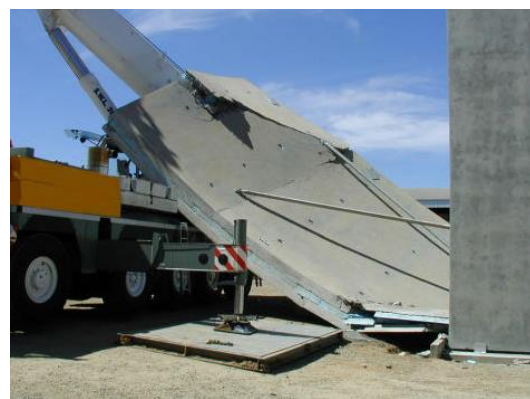
Fig. 159 Errata movimentazione
