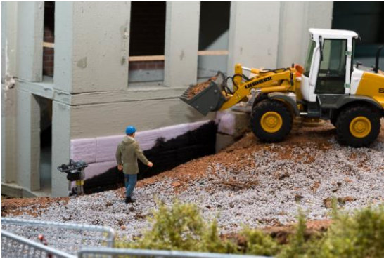
Fig. 201 Reinterro laterale
