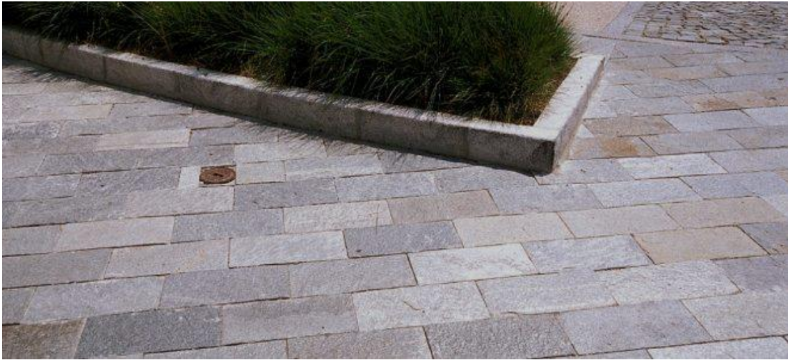
Fig. 112 Applicazione pietra di Luserna per esterni
