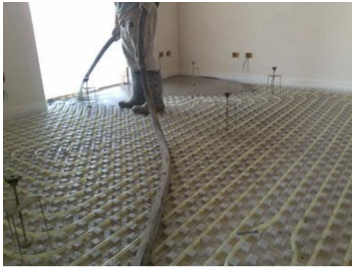
Fig. 219 Posa in opera riscaldamento
