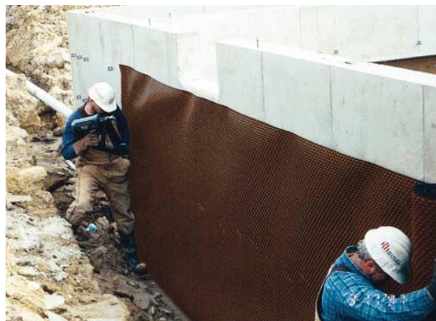
Fig. 200 Fasi di posa in opera
