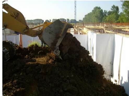
Fig. 202 Fasi del reinterro
