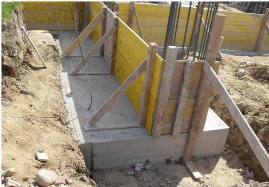
Fig. 189 Casseratura parte superiore
