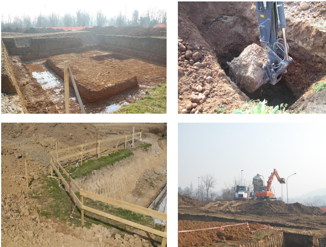
Fig. 170 Scavi tipo, recinzioni e protezioni scarpate e scavi a sezioni ristrette
