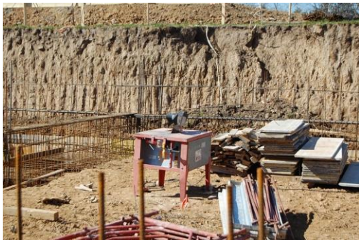
Fig. 185 Fasi di lavoro
