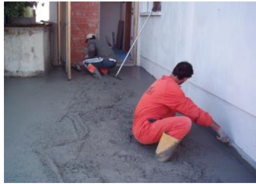
Fig. 220 Posa in opera sottofondo
