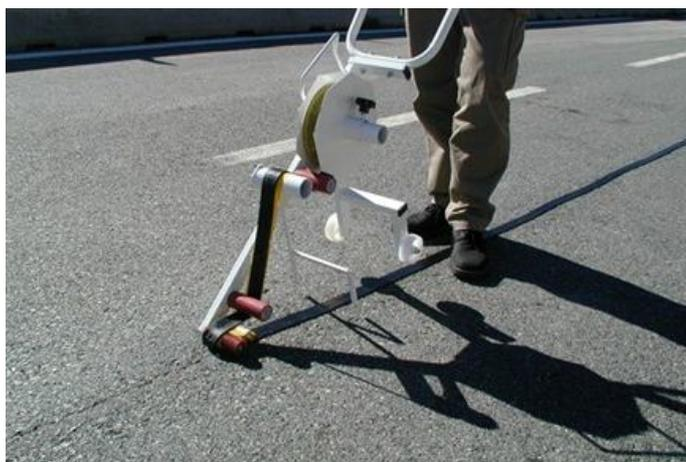
**Figura B.1: Sigillatura con nastri preformati**
