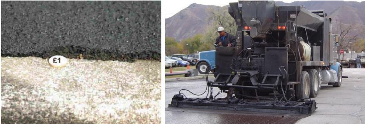
Figura B.6: (a) Slurry Seal: prima e dopo l'applicazione del trattamento; (b): macchina per lo Slurry Seal
