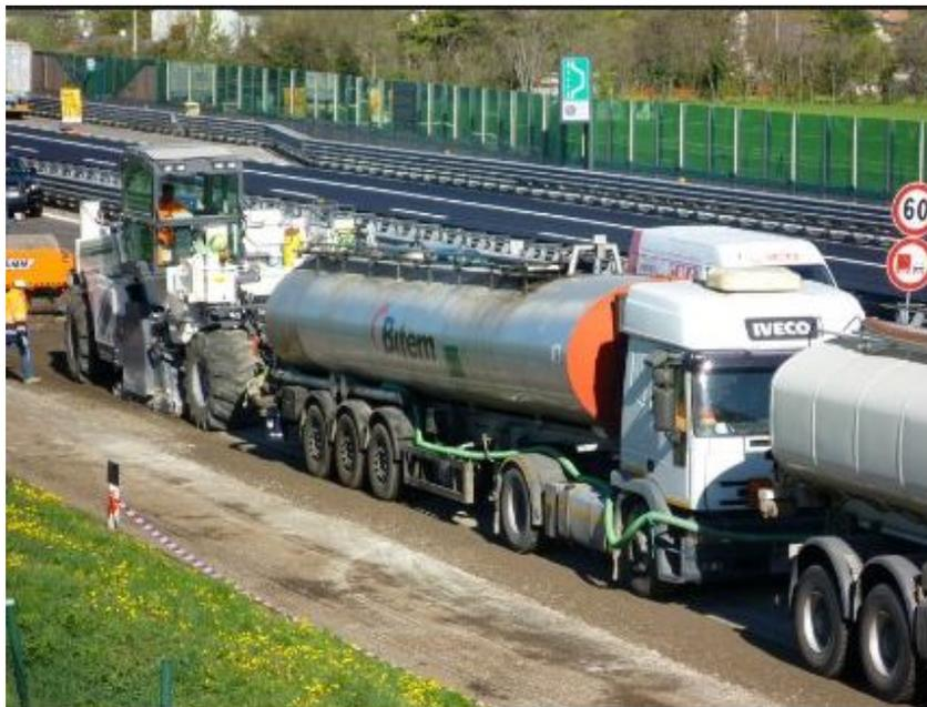
Figura B.8: treno di macchine per il riciclaggio a freddo
