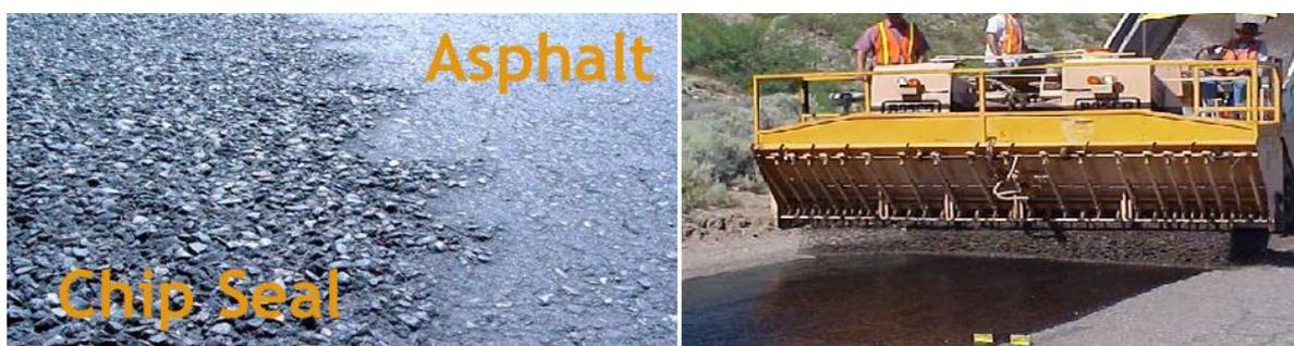
**Figura B.5: (a) Chip Seal: prima e dopo l'applicazione del trattamento; (b): macchina per il Chip Seal**
