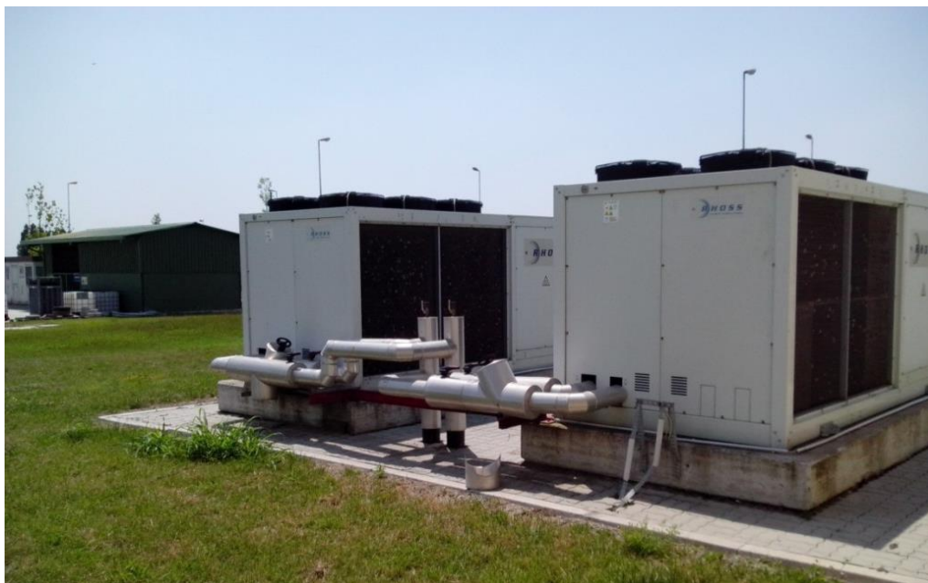
Figura 2.7 Fotografia dei due frigoriferi a compressione di vapore TCAE 4180
