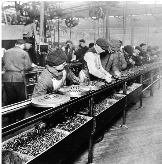
#3 Catena di montaggio all'interno della fabbrica Ford per la creazione del Modello T, prima automobile prodotta in serie (sopra)
