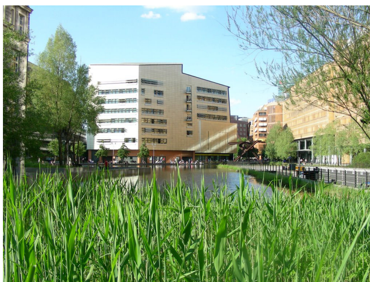
Fig.10 Un esempio di fitodepurazione a flusso libero
