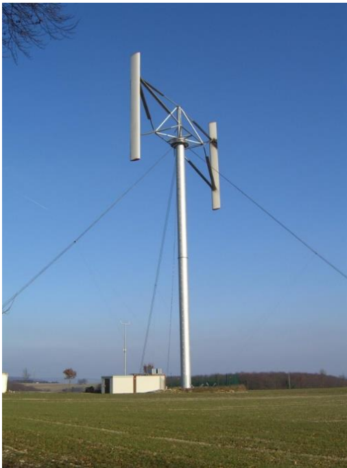
Figura 5 - Turbina di tipo "H-Darrieus"
