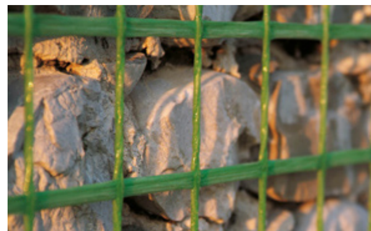
FIG. 42. PARTICOLARE DELLA RETE IN FIBRA DI VETRO PER IL RINFORZO STRUTTURALE
