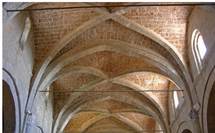
FIG. 39. PARTICOLARE DELLE CATENE SOTTO LE VOLTE PER CONTRASTARE LE SPINTE ORIZZONTALI
