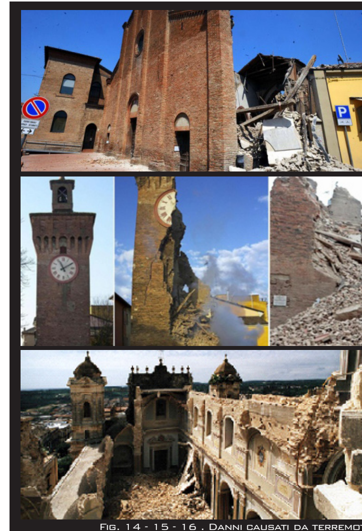
FIG. 14 - 15 - 16 . DANNI CAUSATI DA TERREMOTI
