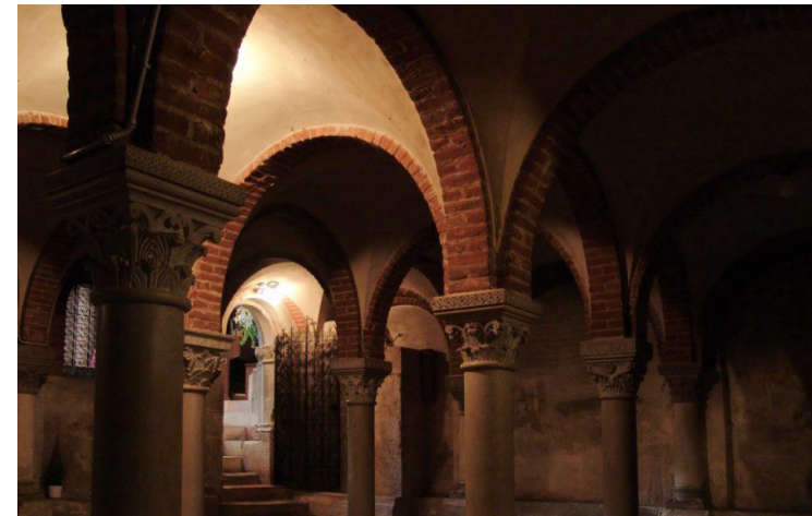
FIG. 9. ARCHI IN MURATURA SOSTENUTI DA COLONNE
