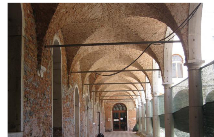
FIG. 30. CATENE DI COLLEGAMENTO DELLE VOLTE
