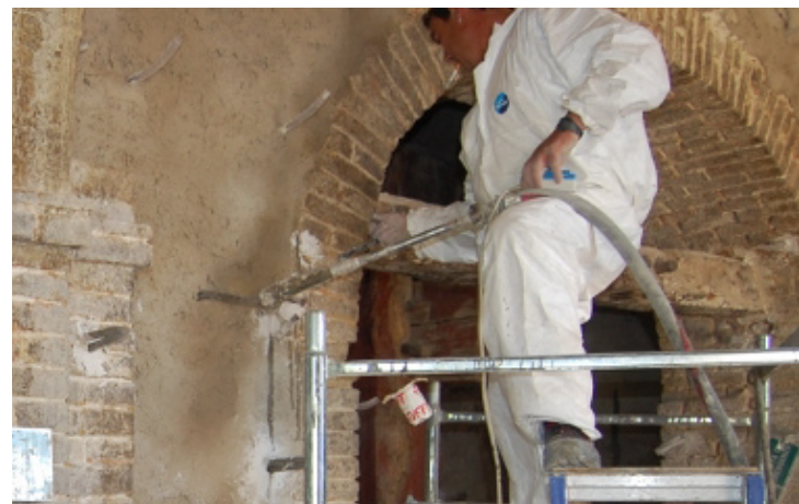
FIG. 36. ESEMPIO DI INIEZIONI NELLA MURATURA PER MIGLIORARE LA RESISTENZA
