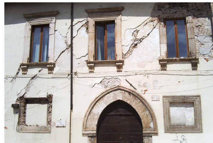
FIG. 25-26. ESEMPI DI COLLASSO NEL SUO PIANO. MECCANISMO DI ROTTURA PER TAGLIO
