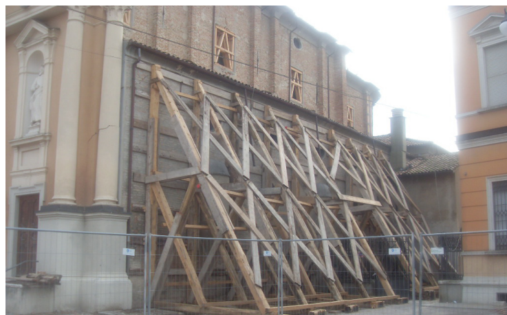
FIG. 40. PARTICOLARE DELL'INTERVENTO PROVVISORIO IN LEGNO PER LA MESSA IN SICUREZZA
