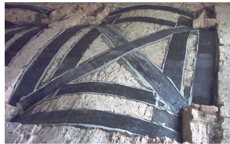
FIG. 41. PARTICOLARE DELL'INTERVENTO DI RINFORZO DELLA VOLTA IN FIBRE DI CARBONIO
