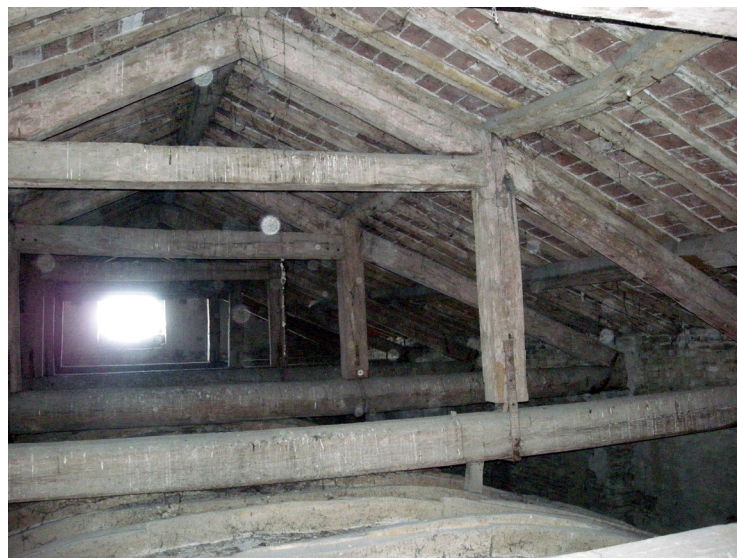
FIG. 89. VEDUTA DEL SOTTOTETTO SOSTENUTO DA CAPRIATE LIGNEE
