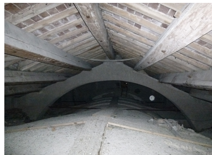
FOTO. 109. SOTTOTETTO CON ARCO CHE SORMONTA LE VOLTE SOTTOSTANTI A SOSTEGNO DELLA COPERTURA
