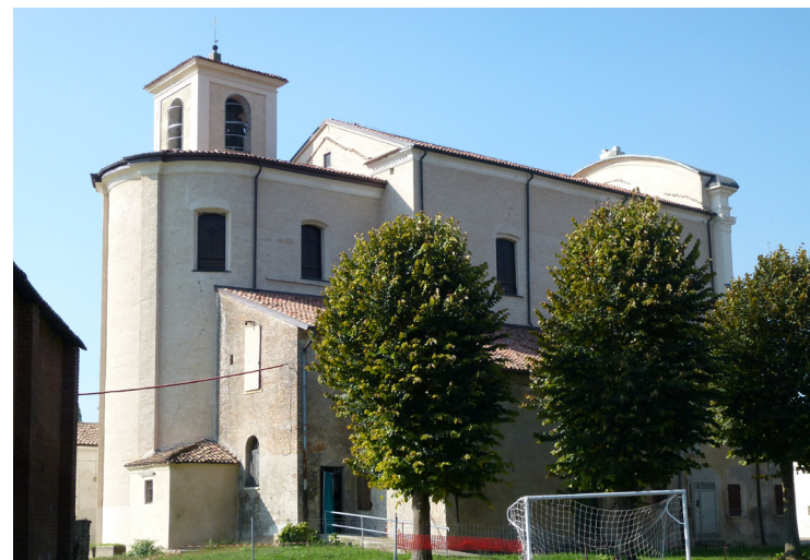
FIG. 124. VISTA LATERALE CON CORPI ADDOSSATI ALLA CHIESA
