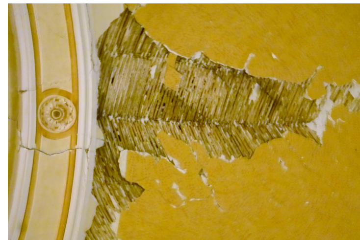
FOTO. 129. LESIONI SULLE VOLTE IN CANNUCCIATO
