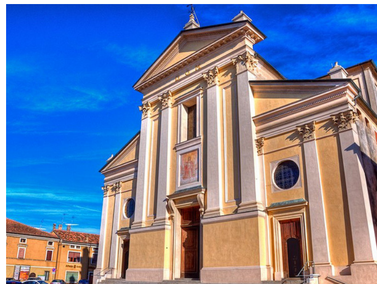
FIG. 108. FACCIATA DELLA CHIESA
