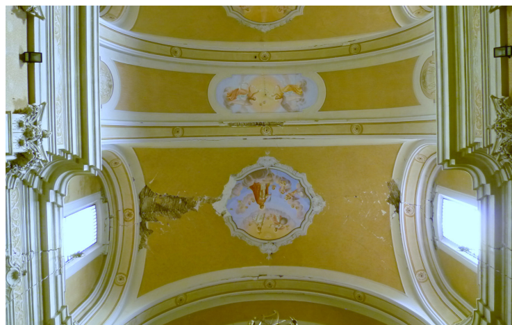
FIG. 120-121. VOLTE INTERNE IN CANNUCCIATO
