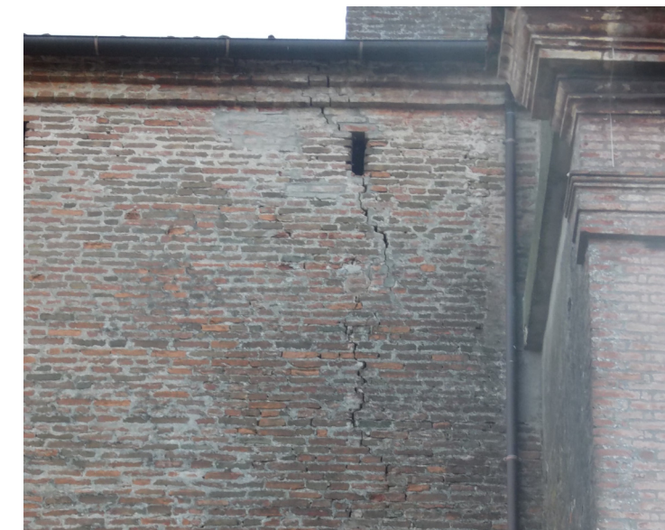
FIG. 142. LESIONE SUL MURO LONGITUDINALE DELLA CHIESA IN PROSSIMITÀ DELLA FACCIATA
