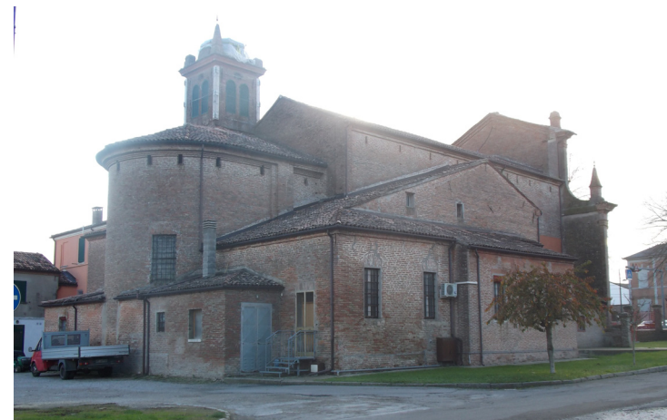
FIG. 137. VEDUTA DELL'ABSIDE E DEL FIANCO DELLA CHIESA DI VIGARANO PIEVE
