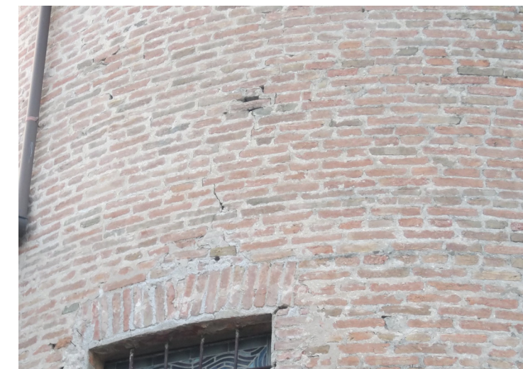
FIG. 146. LESIONE SULL'ABSIDE
