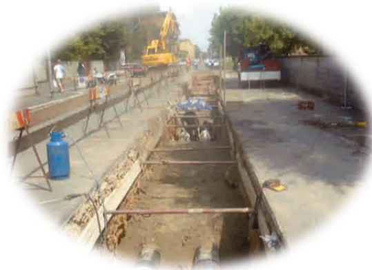
Figura 5.1 - Lavori per l'installazione della rete di teleriscaldamento a San Fermo, Credaro.
