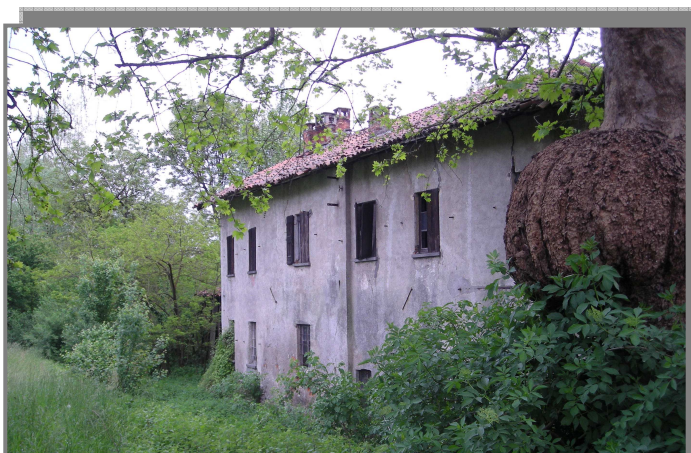
Figura 22: Quello che rimane della roggia molinara lungo il lato nord dell'edificio "mulino."
