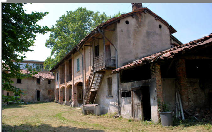
Figura 9: Vista generale dell'edificio "Mulino".
