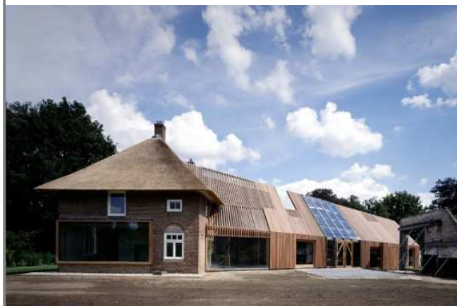
Figura 19: Ristrutturazione di una fattoria a Zutphen (NL), Search Architects.
