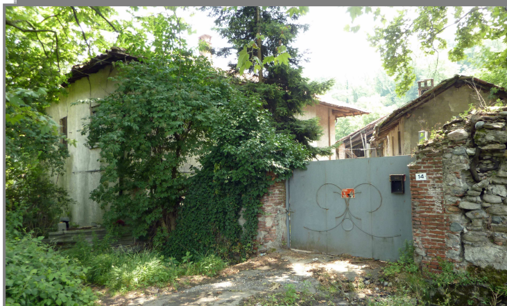
Figura 8: Ingresso attuale dell'area di progetto.
