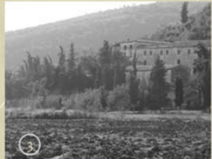
3_ Grancia di Tecchiena vista dal sentiero di accesso
