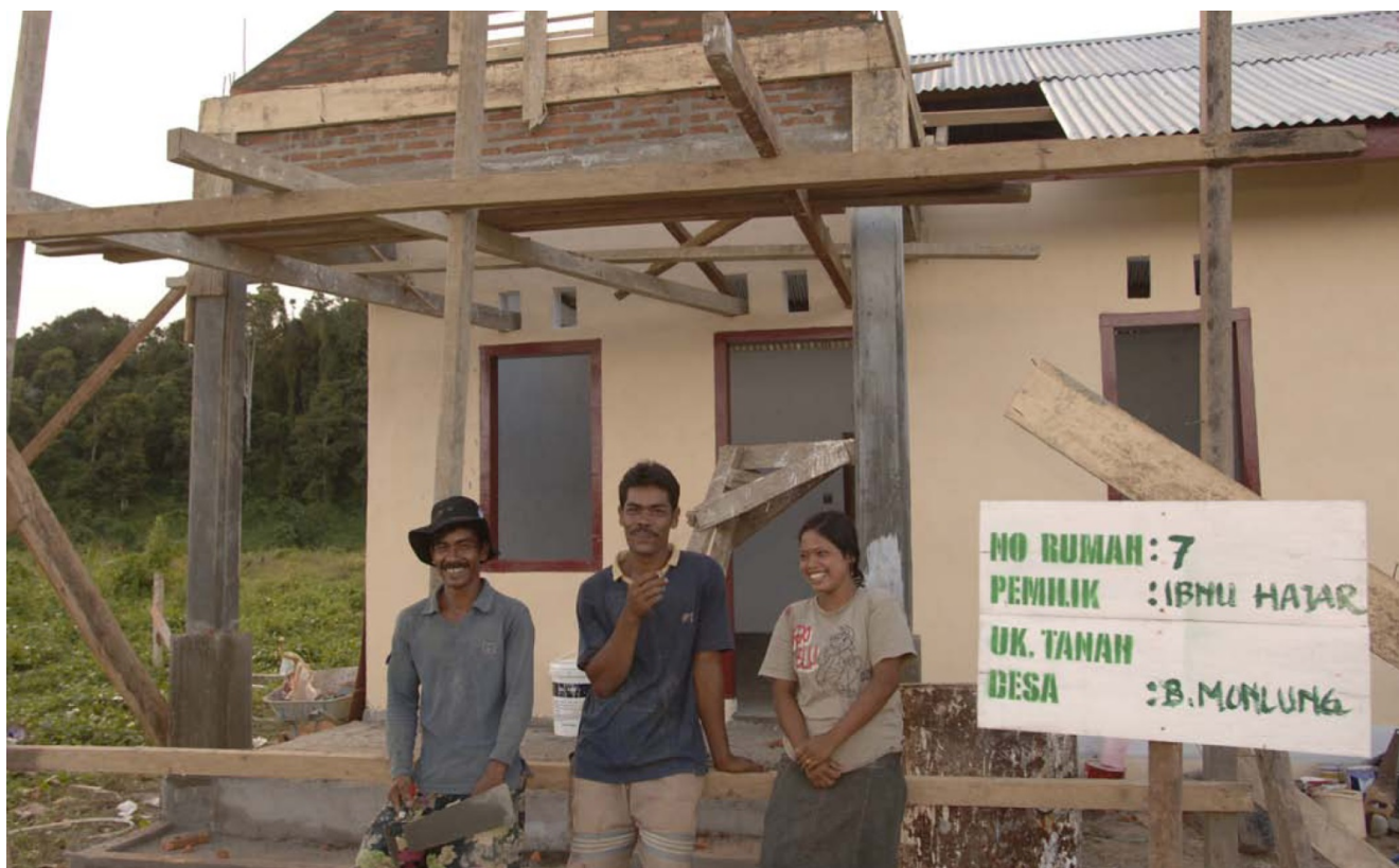
15 In Indonesia, una casa viene modificata per elevarsi ai nuovi standard anti tsunami dopo lo tsunami del 2004.
