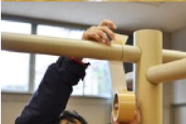
Assemblaggio del Paper Partition System 4.
