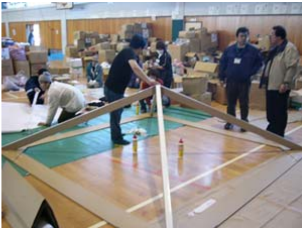
Costruzione dei Paper Partition System 1 e 2.
