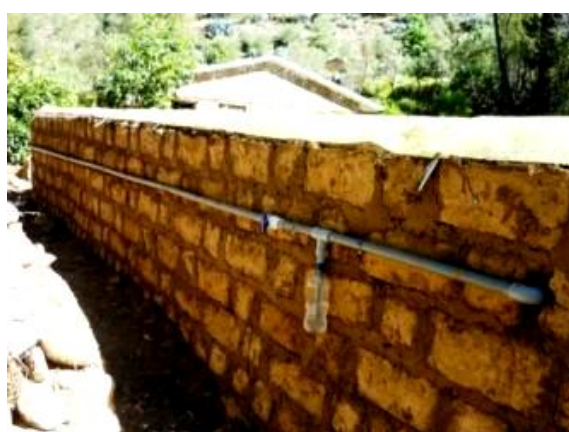
Figura 3.27 Fasi dell'operazione di installazione delle tubazioni di collettamento del biogas.
