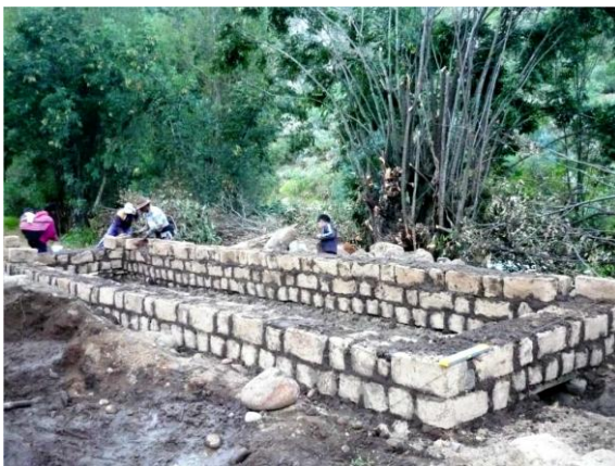
Figura 3.18 Elevazione delle pareti della serra.
