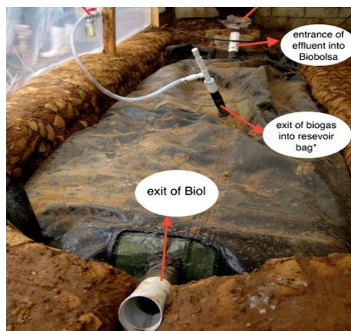
Figura 2.13 Componenti principali di un digestore tubolare plastico.
