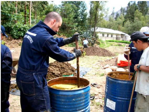
Figura 3.26 Fasi dell'operazione di carica del digestore.
