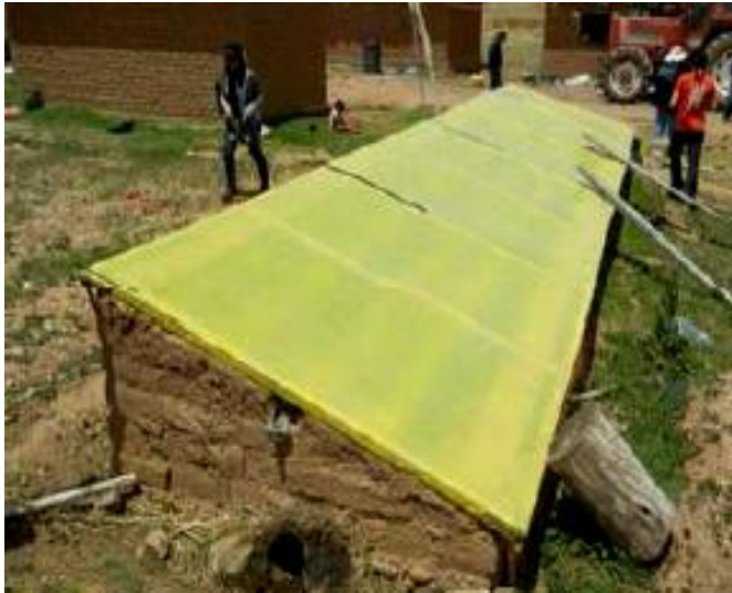
Figura 2.31 Visione esterna della serra in cui viene spesso collocato digestore tubolare.
