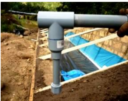
Figura 3.30 Installazione della trappola dell'acqua.
