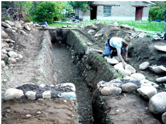
Figura 3.14 Posizionamento del materiale di consolidamento.
