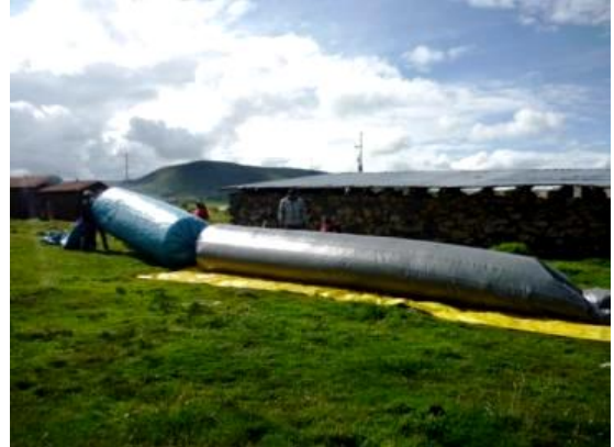
Figura 3.23 Digestore in fase di gonfiaggio.
