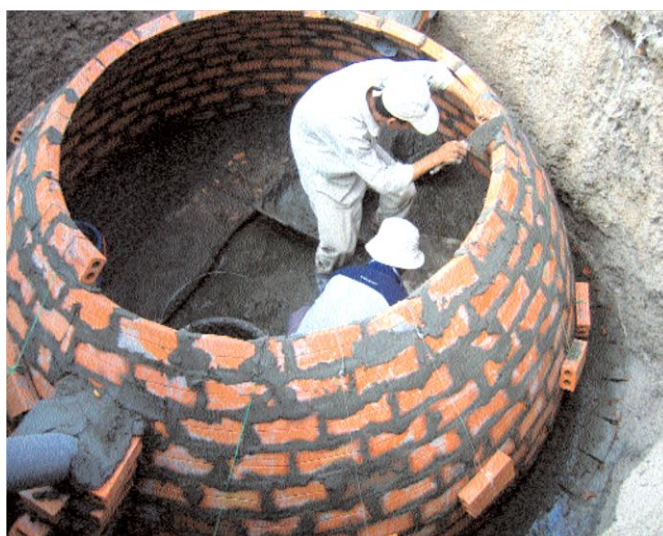
Figura 2.7 Costruzione del digestore CAMARTEC.
