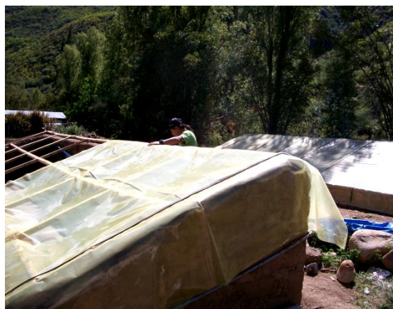
Figura 3.33 Posizionamento dell'agrofilm.
