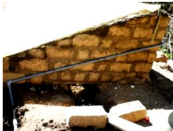
Figura 3.27 Fasi dell'operazione di installazione delle tubazioni di collettamento del biogas.
