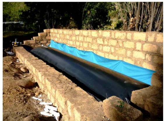
Figura 3.25 Digestore posizionato nella fossa.
