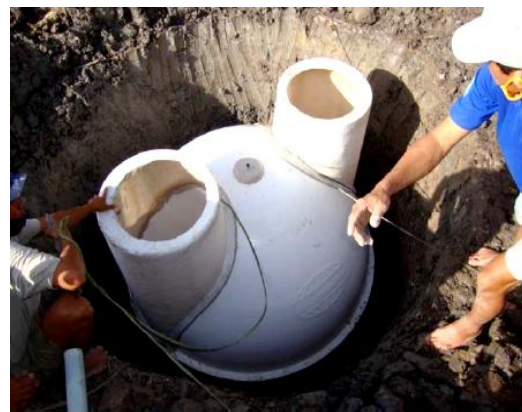
Figura 2.30 Installazione del Composit Model.
