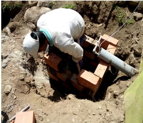
Figura 3.40 Costruzione del pozzetto di raccolta del biol.
