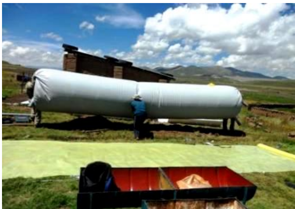
Figura 3.24 Operatori intenti a posizionare il digestore nella fossa
