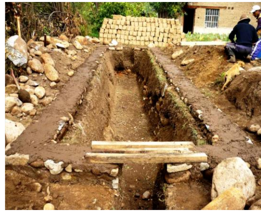
Figura 3.15 Livellazione del terreno di fondazione.
