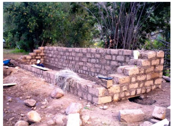
Figura 3.19 Completamento delle operazioni di realizzazione della struttura portante della serra.
