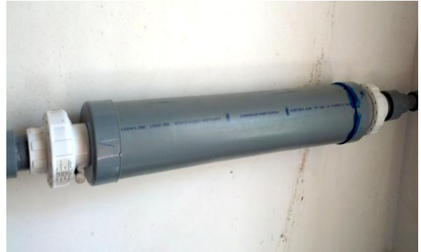
Figura 3.31 Desolforatore.
