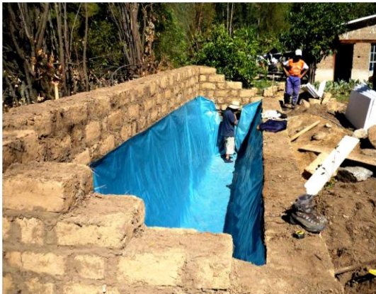
Figura 3.20 Posizionamento strato isolante in LDPE.
