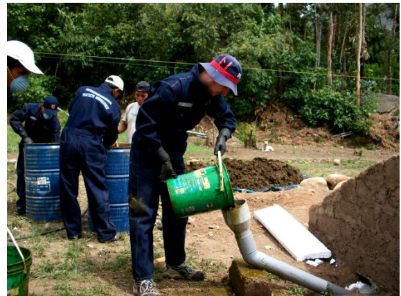
Figura 3.26 Fasi dell'operazione di carica del digestore.
