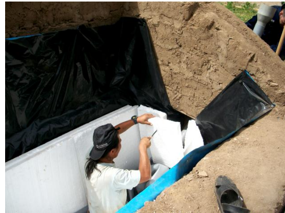
Figura 3.21 Posizionamento strato isolante in PS.
