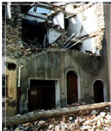
66_ Il paese di Nocera danneggiato dal sisma.
