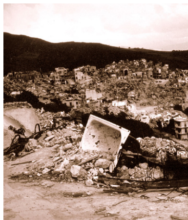
35_ La forza distruttrice del terremoto a Gibellina.
