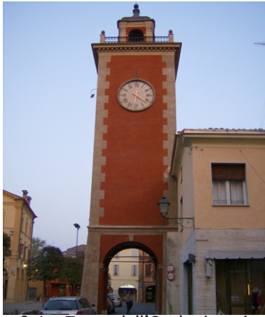
148_ La Torre dell'Orologio prima del sisma.
