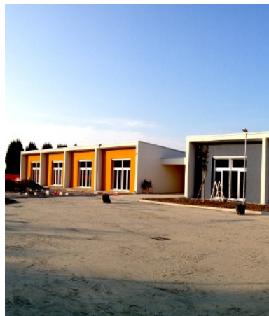
116_ Scuole primarie prefabbricate, nel nuovo polo scolastico.
