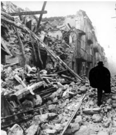
55_Paesi distrutti dal terremoto.
