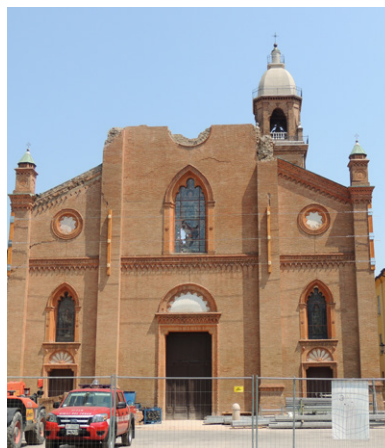
131_Duomo di Mirandola, dopo il terremoto.
