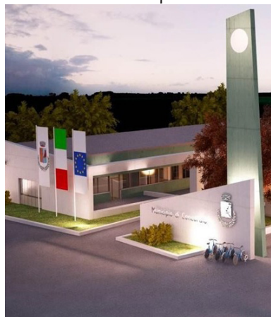
119_ Il Municipio di Concordia, messo in sicurezza dopo il sisma.
