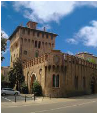
128_Castello dei Pico, prima del terremoto.
