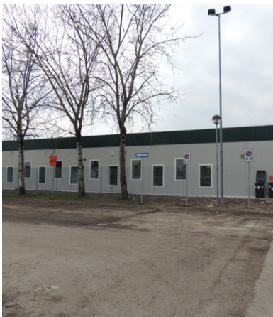
144_Nuovo Complesso scolastico a Rovereto sulla Secchia.
