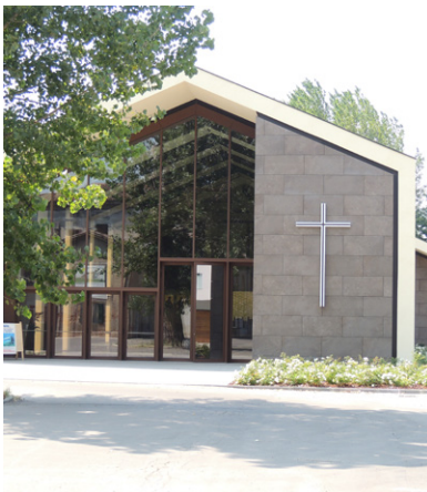
126_Nuova Chiesa edificata a Medolla.
