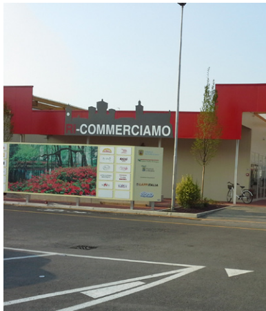
171_Centro commerciale Ricomerciamo, a San Felice sul Panaro.
