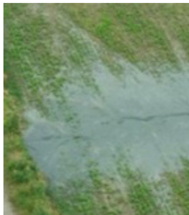
92_ Esempio di liquefazione delle sabbie.
