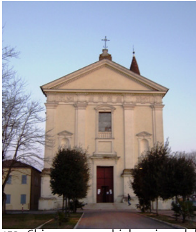
152_Chiesa parrocchiale prima del sisma.
