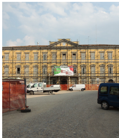
118_ Il Municipio di Concordia, messo in sicurezza dopo il sisma.
