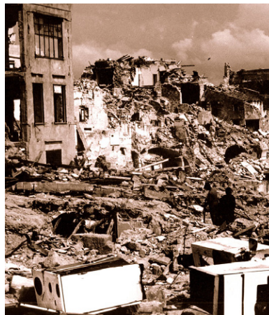
33_ Interi paesi completamente distrutti dal terremoto.
