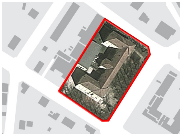
206 Area delle scuole gravemente danneggiate a Concordia.
