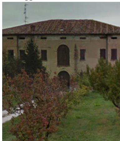
113_Casa Motta prima del sisma.
