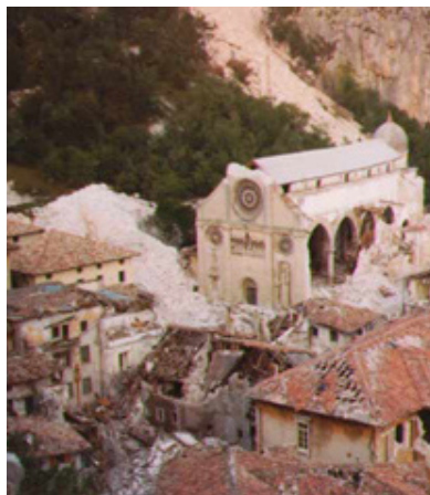
50 Comune di Gemona: il centro distrutto dal sisma.
