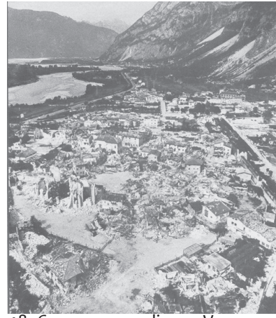
48 Comune di Venzone: distrutta dal sisma.
