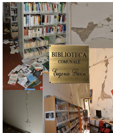
138_Biblioteca Comunale vista interna dopo il terremoto.
