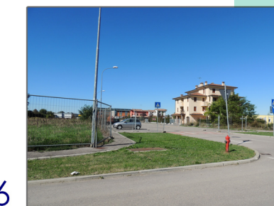
6 Vista del nuovo tratto di via Malcantone
