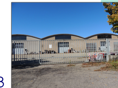
3 Edificio della fabbrica dismessa
