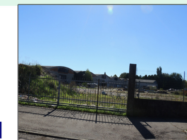
1 Area retrostante la fabbrica dismessa
