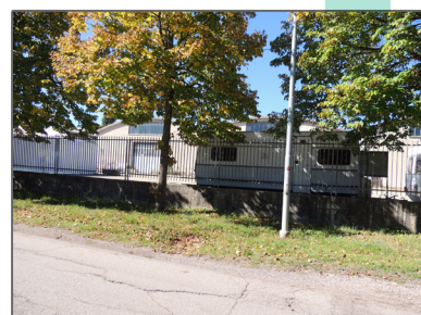
10 Roulotte di fronte alla fabbrica di via Fratelli Cervi
