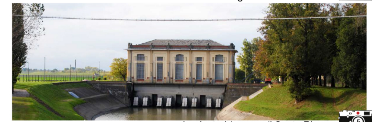
Impianto idrovoro di Santa Bianca
