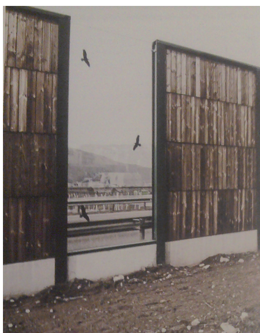
Figura 23. Pineta di Laives. Barriere antirumore
