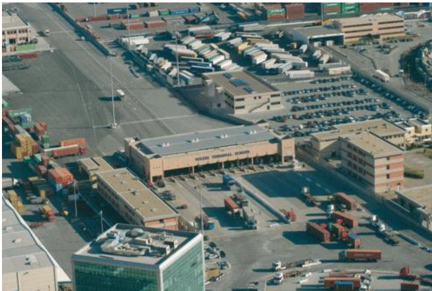
Figura 54: Gate di ingresso/uscita del Voltri Terminal Europa
