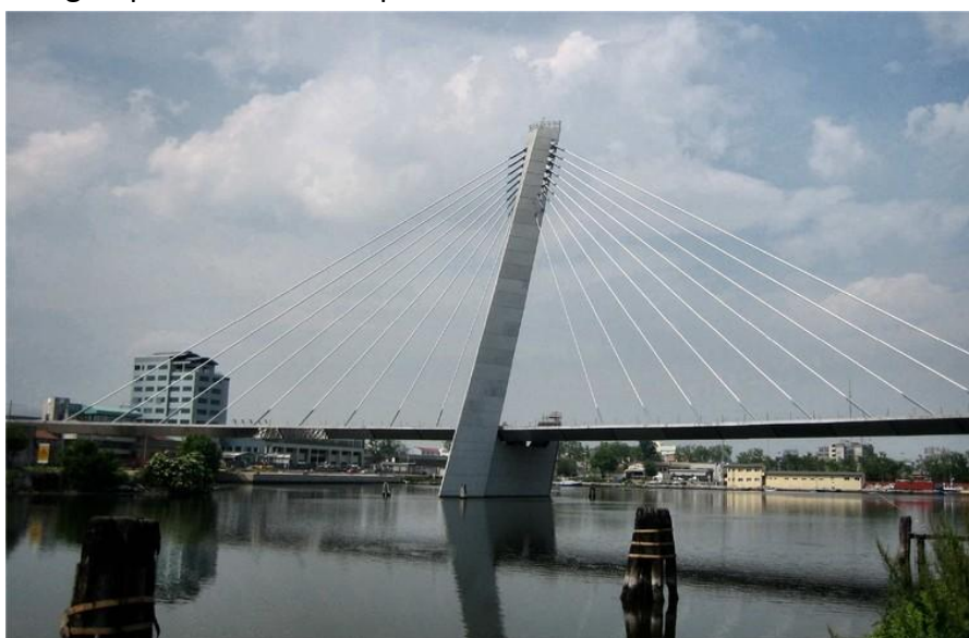
Figura 6. Ponte Strallato sul Canale Industriale Ovest
