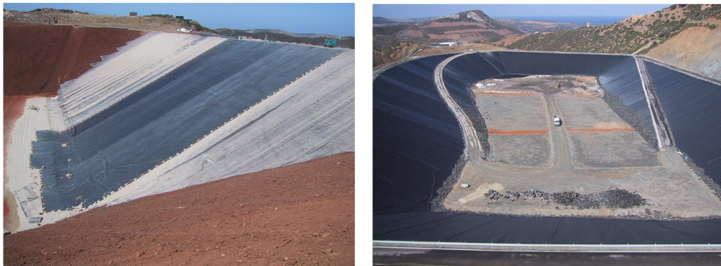
Figura 4.2: Impermeabilizzazione scarpate e fine allestimento della discarica.
