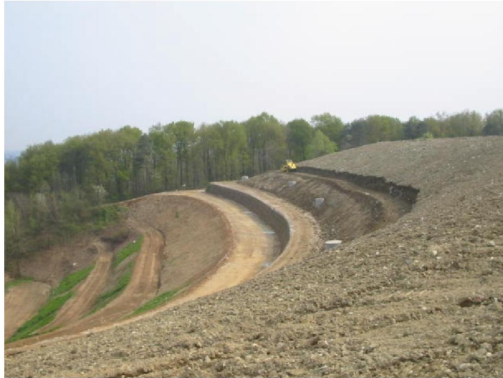
Figura 4.4: Fase conclusiva delle operazioni di copertura.
