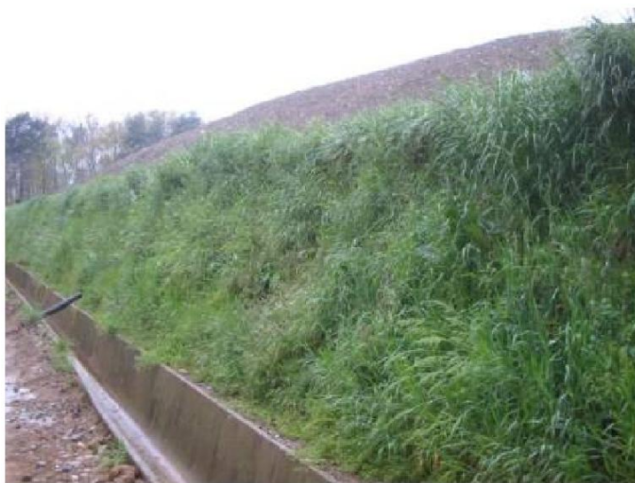
Figura 4.5: Inerbimento argini perimetrali.
