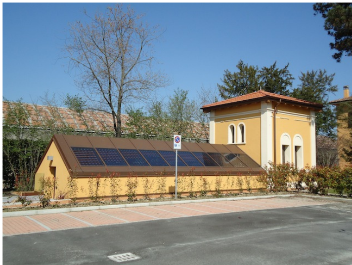
Figura 1.5 Copertura Uffici Villa Zarri (fonte Energy Glass)
