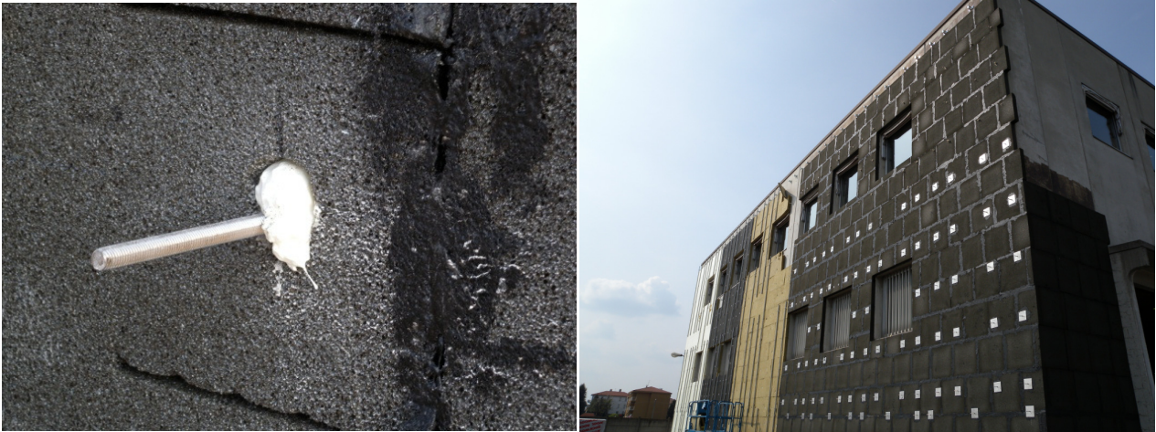
Figura 3.6 Riempimento foro con schiuma poliuretanic
