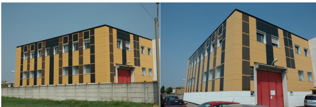
Figura 3.3 Aderma facciata ventilata fotovoltaica
