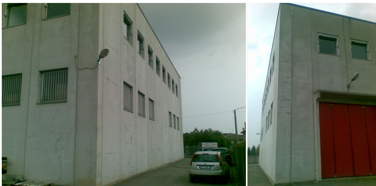
Figura 3.1 Aderma facciata Sud (2009)
