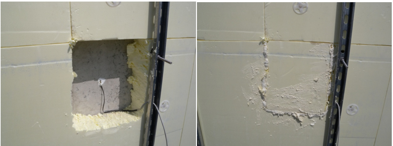
Figura 3.8 Sensore T3 dietro isolante
