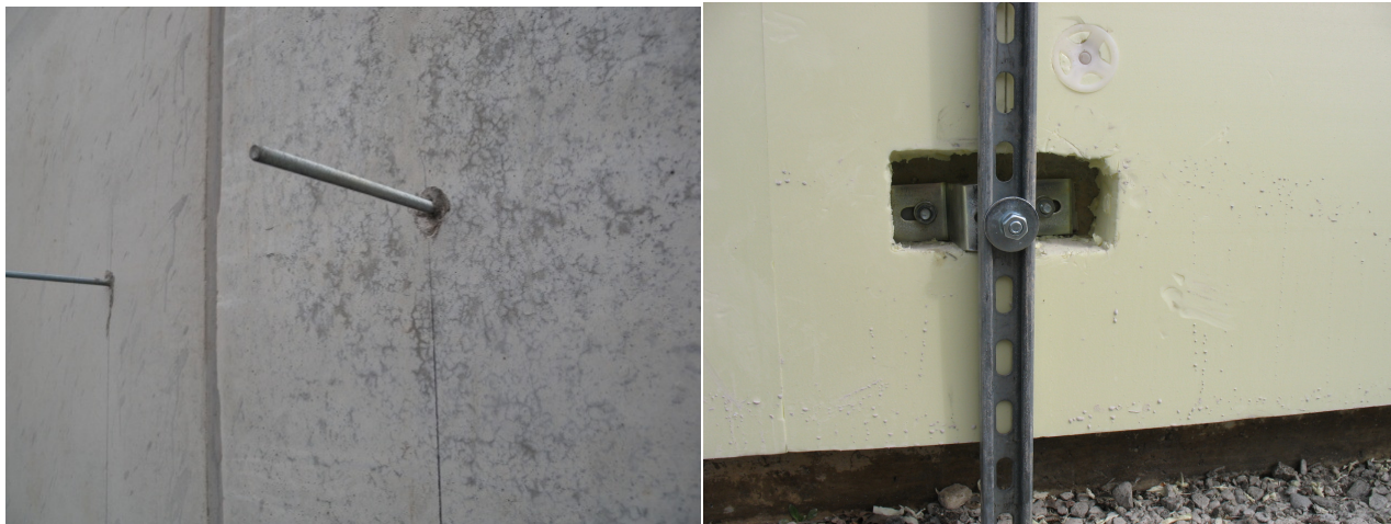
Figura 3.4 Tasselli di controvento ad ancoraggio meccanico
