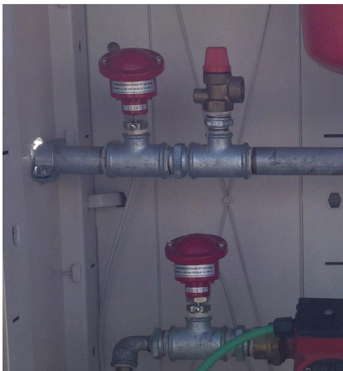
Figura 5.1 –sonda di temperatura PT 100 a immersione con pozzetto
