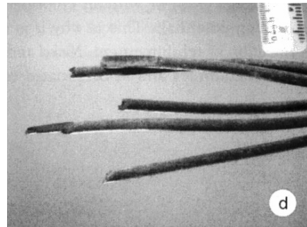
(d) Brittle failures of prestressing tendons.
