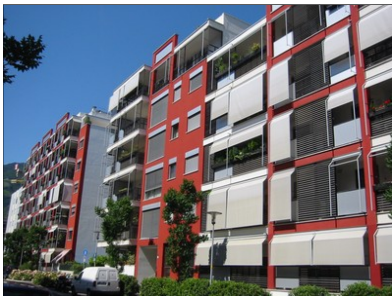
Fig. 2.71 - Schermature solari degli edifici sul fronte della strada di accesso al complesso
