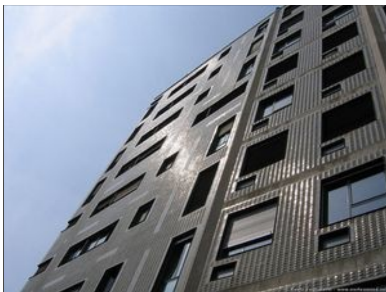
Fig. 3.19 - Particolare della facciata dell'Edificio 14
