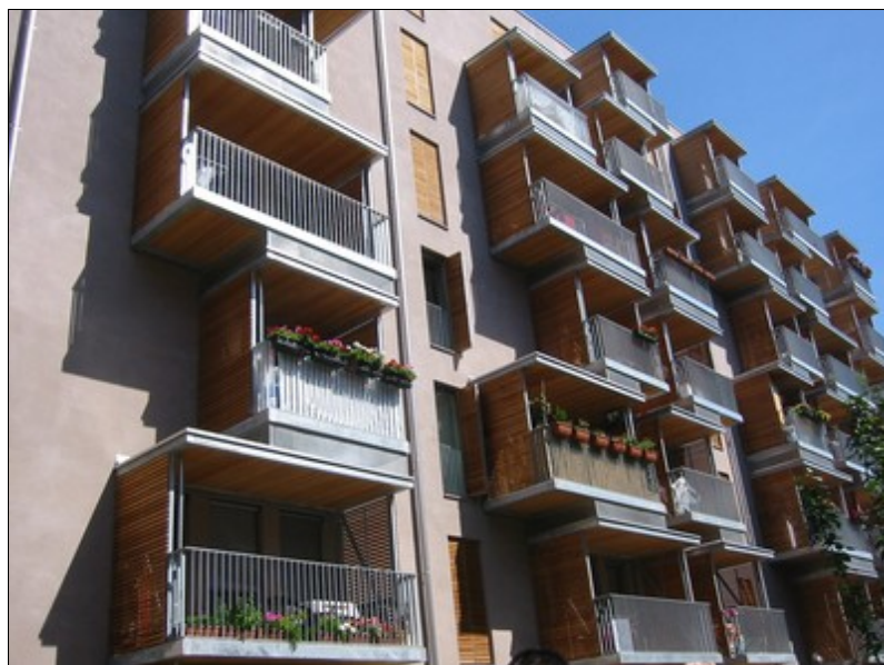
Fig. 2.62 - Edifici della tipologia edilizia EA6
