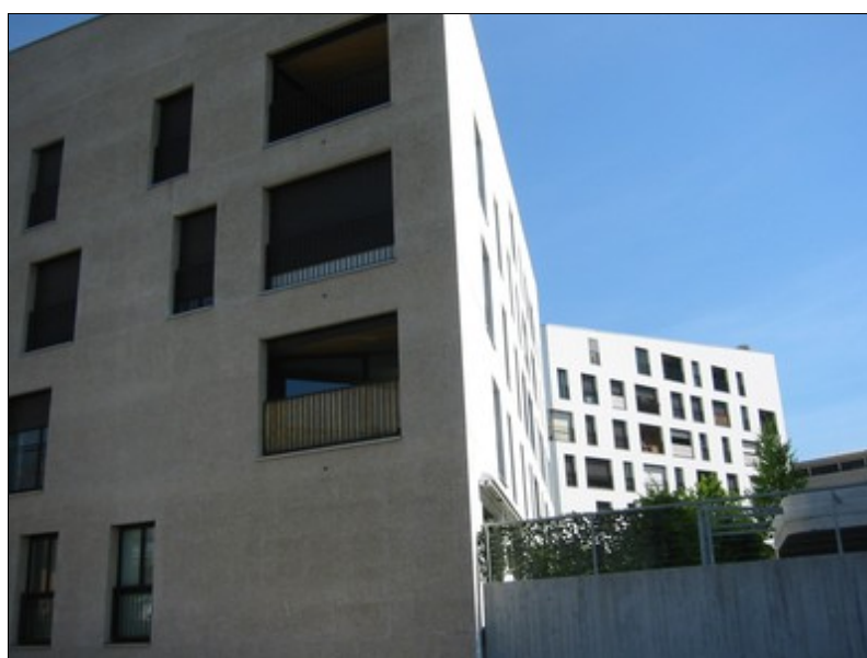
Fig. 2.64 - Edifici della tipologia edilizia EA7
