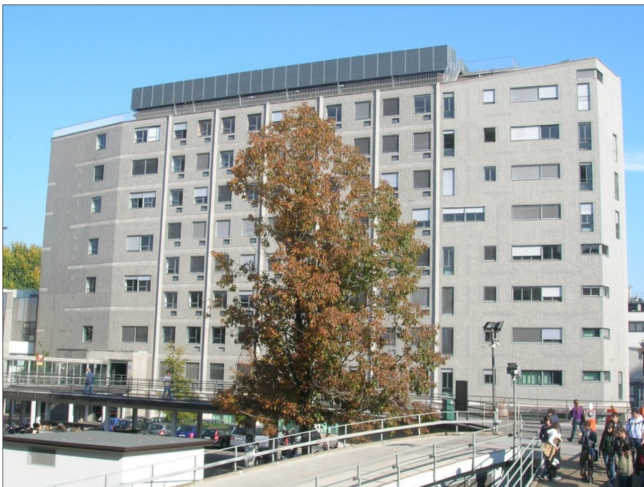
Fig. 3.18 - Facciata Ovest dell'Edificio 14
