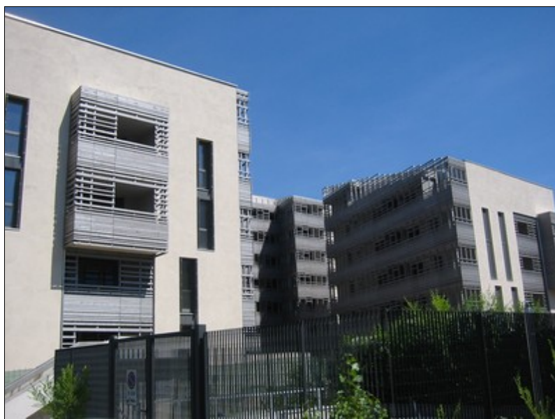
Fig. 2.66 - Edifici della tipologia edilizia EA7
