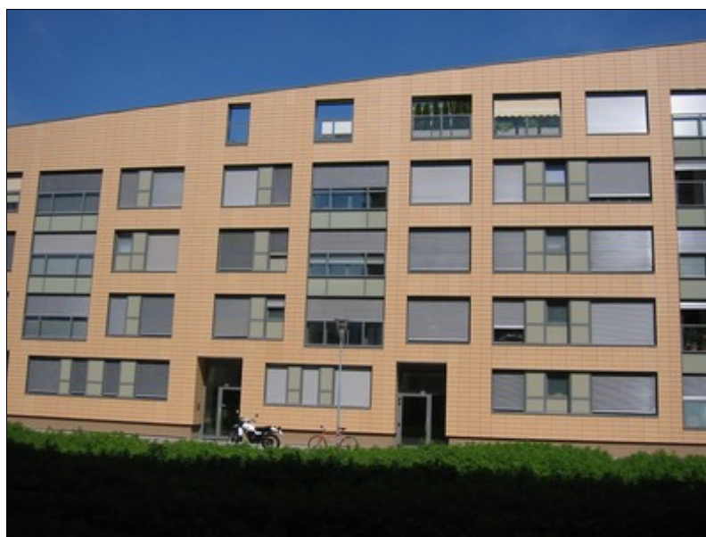
Fig. 2.54 - Edifici della tipologia edilizia EA1
