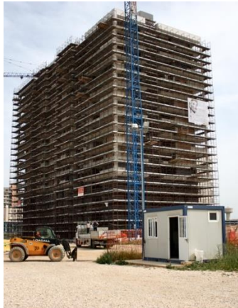
Cantiere Noema, appartamenti Lago, Bari.
