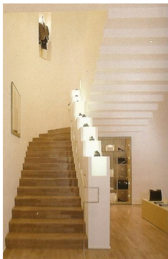
Bally, Ginevra. Il parapetto della scala riprende il tema del progetto convertendosi esso stesso in una scala illuminata fatta di vetro sabbato e retro illuminato per la esposizione delle scarpe.
