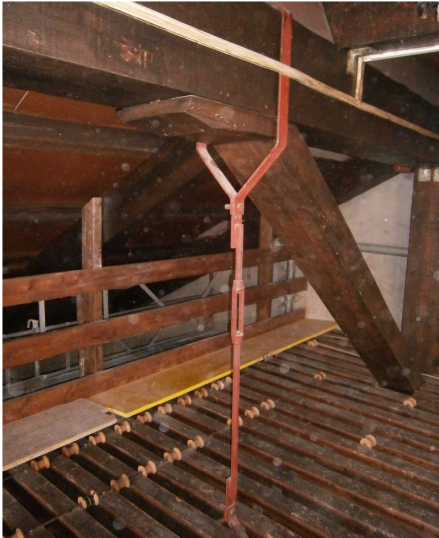
Figura 101 - Tirante in acciaio per collegamento graticcio-trave di copertura
