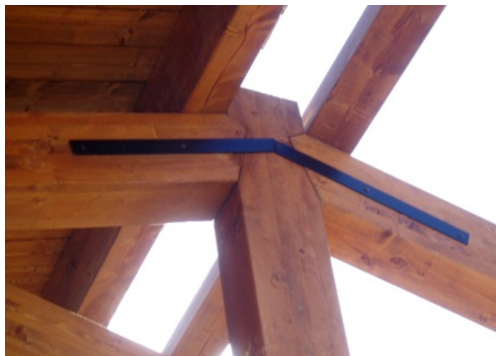
Figura 134 - Esempio collegamento Monaco-Puntone tramite piastra in acciaio
