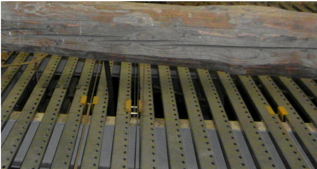
Figura 93 - Particolare del graticcio in acciaio del teatro "De Micheli" di Copparo
