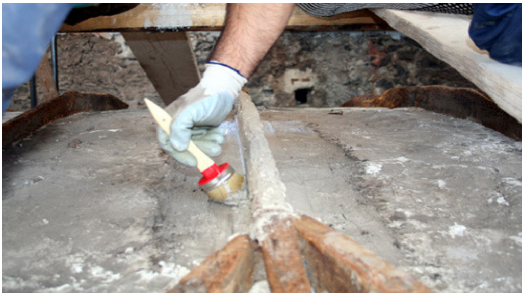
Figura 153 - Stuccatura dell'estradosso
