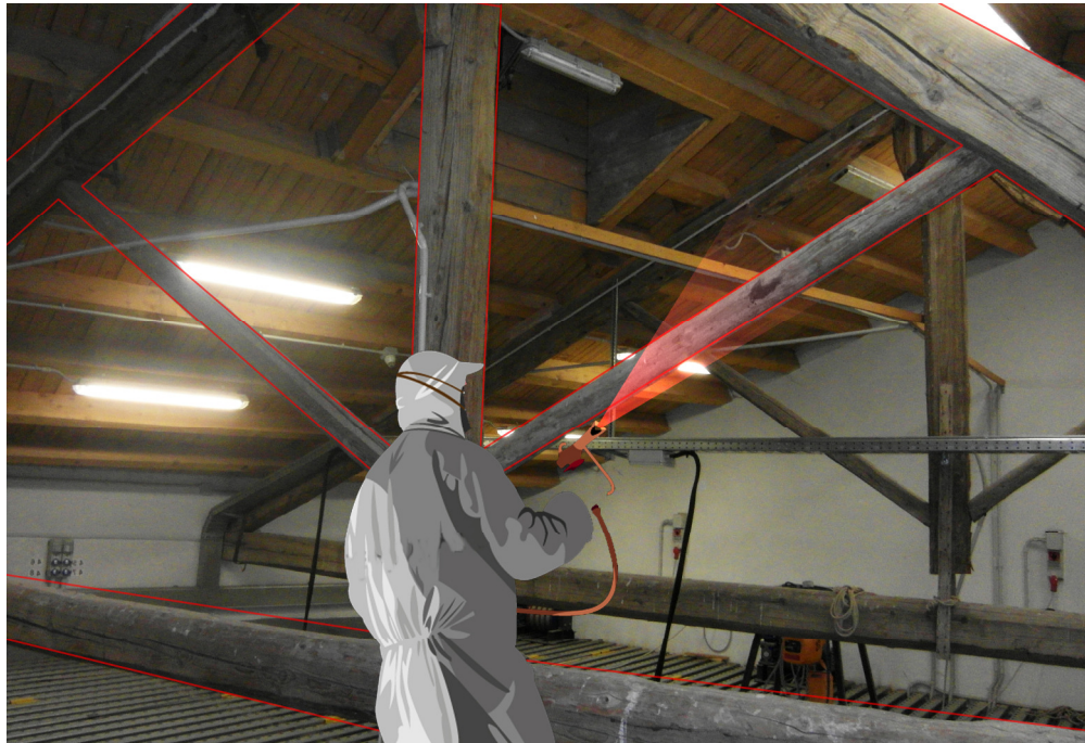
Figura 120 - Applicazione vernice intumescente sulla capriata in legno
