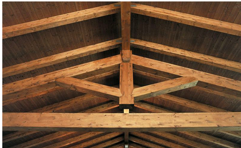
Figura 158 - Capriata in legno dopo l'applicazione di vernice ignifuga
