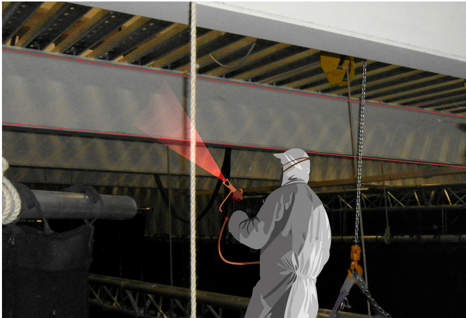
Figura 113 - Applicazione intonaco protettivo su trave principale del piano graticcio
