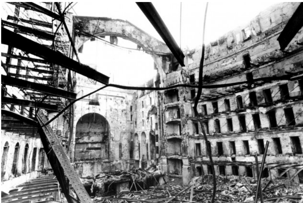
Figura 22 - L'interno del Teatro Liceu dopo l'incendio
