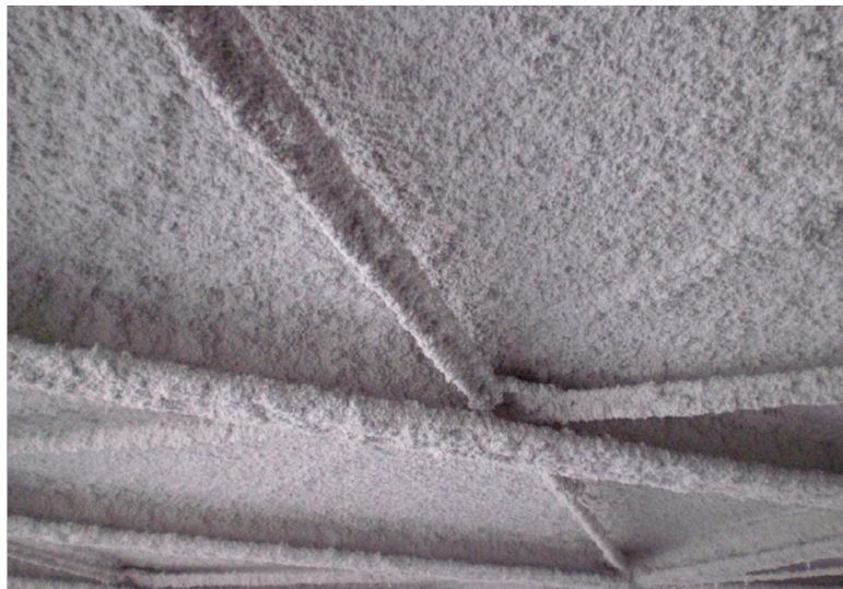
Figura 162 - Intonaco a base di lana minerale su elementi strutturali
