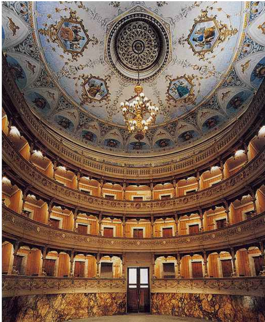
Figura 64 – Vista della volta del teatro Comunale – Cagli (PU)
