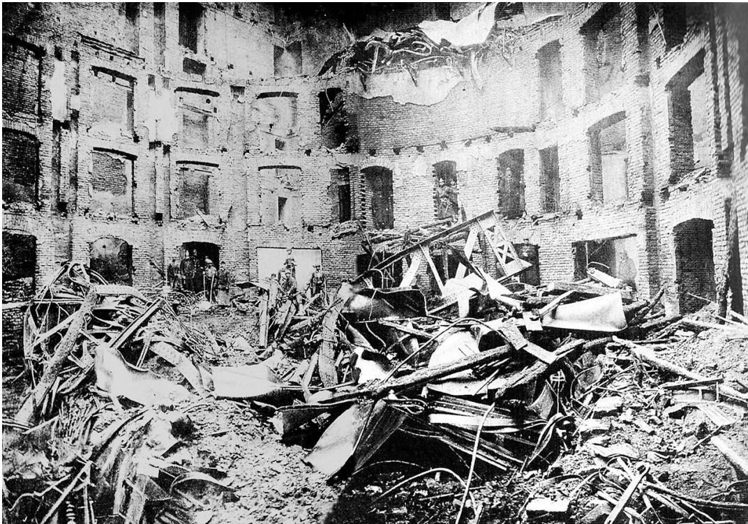
Figura 10 - I resti del teatro di Vienna subito dopo l'incendio
