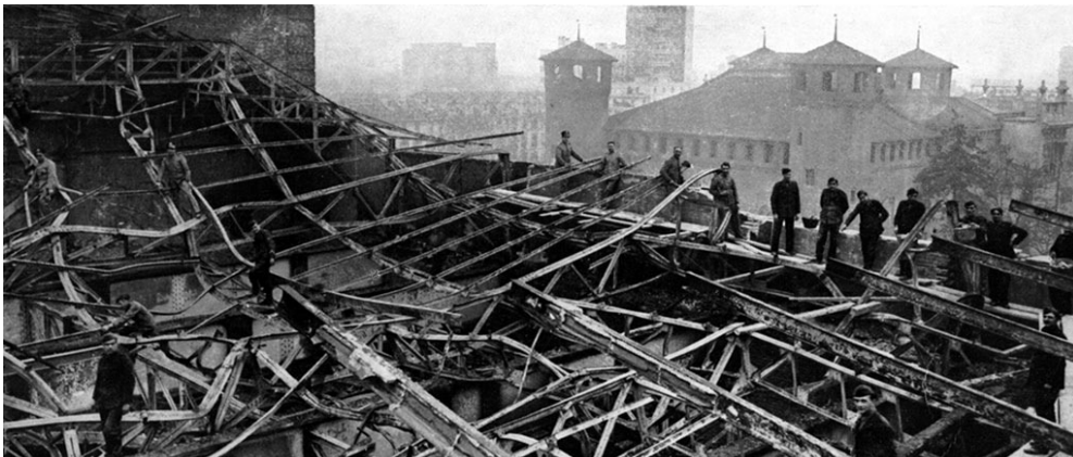
Figura 49 - Copertura del Teatro "Regio" di Torino dopo l'incendio del 1936
