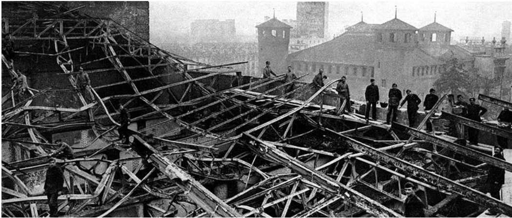
Figura 19 - La copertura del teatro crollata a causa delle fiamme
