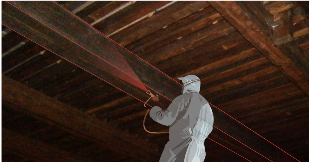
Figura 99 - Applicazione di vernice intumescente su trave principale del piano graticcio
