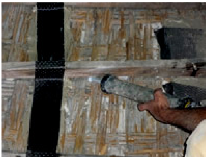
Figura 149 - Applicazione di un cordone di resina epossidica tra centina e stuoiato
