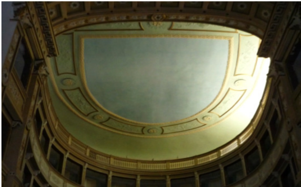
Figura 137 - Il plafone del teatro "dei Filarmonici" dopo l'intervento
