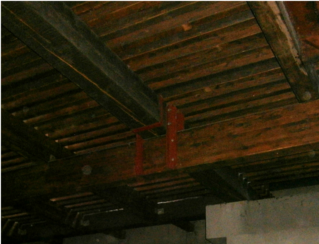
Figura 107 - Elemento di rinforzo a "L"
