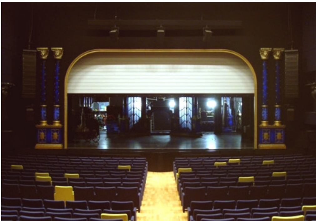
Figura 46 - Sipario di sicurezza tagliafuoco del Teatro "Nazionale" di Milano
