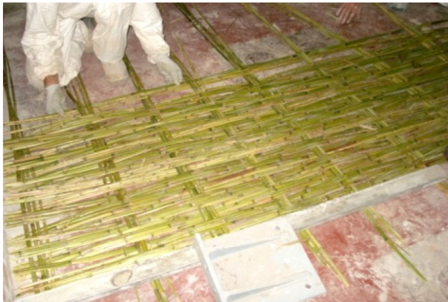
Figura 148 - Realizzazione del nuovo stuoiato
