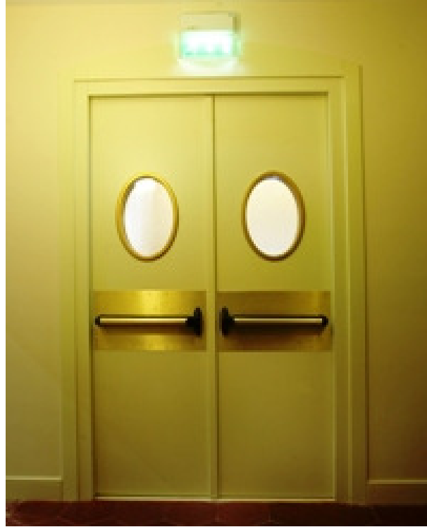
Figura 87 - Porta REI dotata di dispositivo di autochiusura
