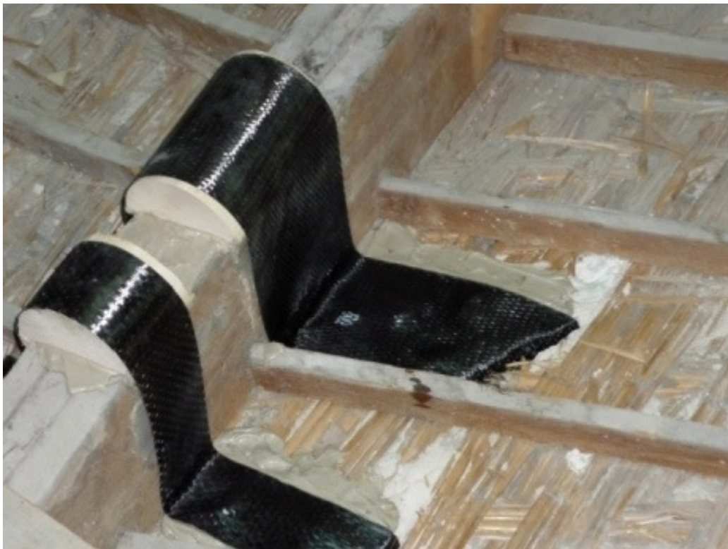
Figura 155 - Dettaglio del consolidamento tramite FRP
