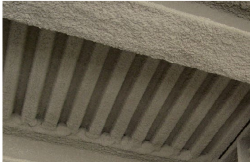
Figura 161 - Applicazione di intonaco a base di gesso su elementi strutturali
