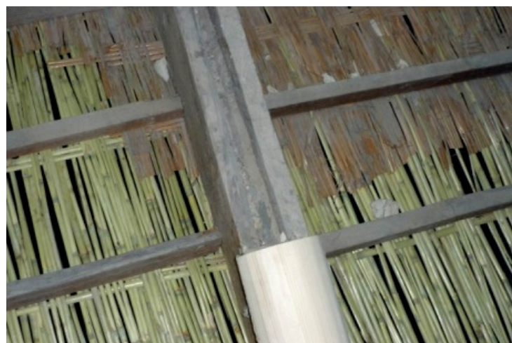
Figura 152 - Sovrapposizione dello stuoiato nuovo con il vecchio
