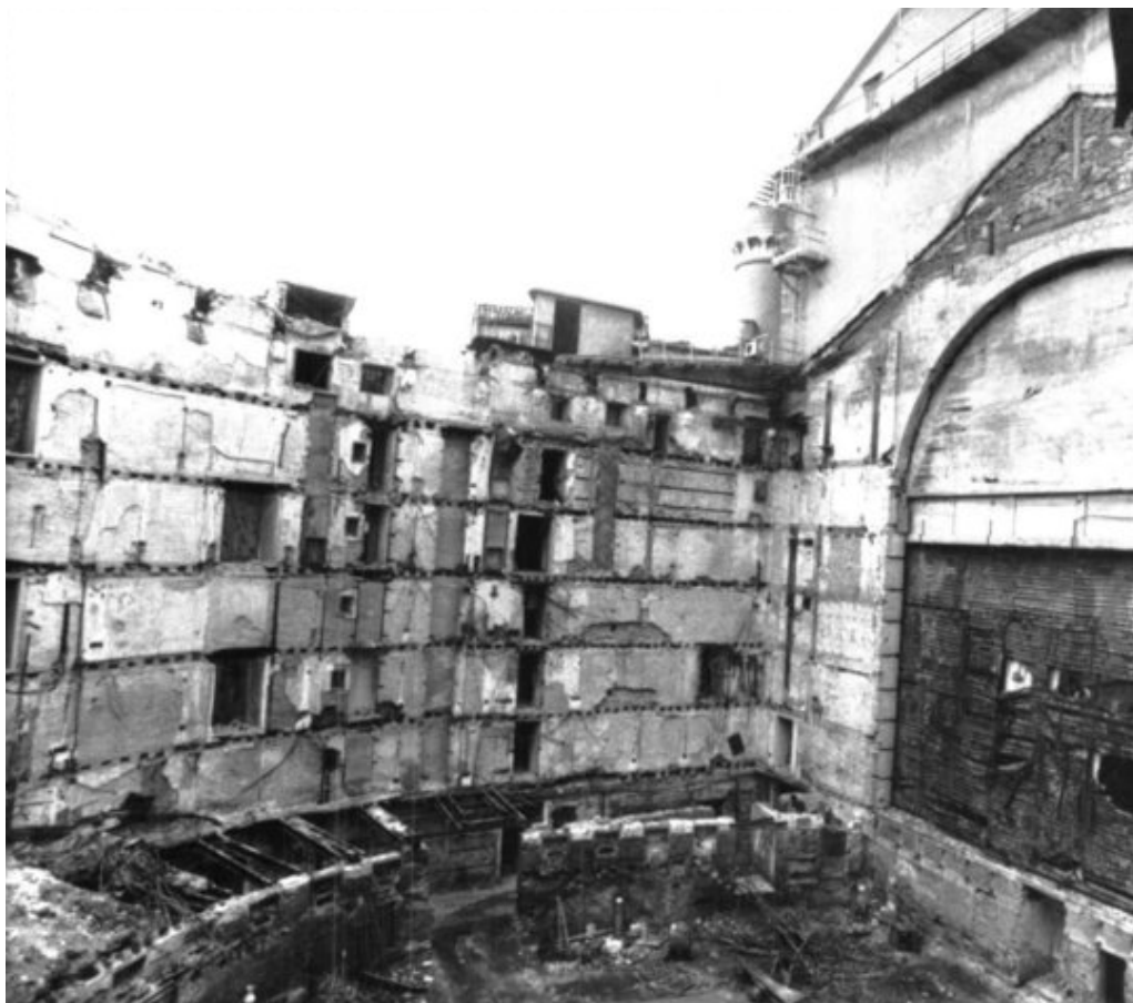
Figura 24 - L'interno del Teatro la Fenice il giorno successivo all'incendio del 1996
