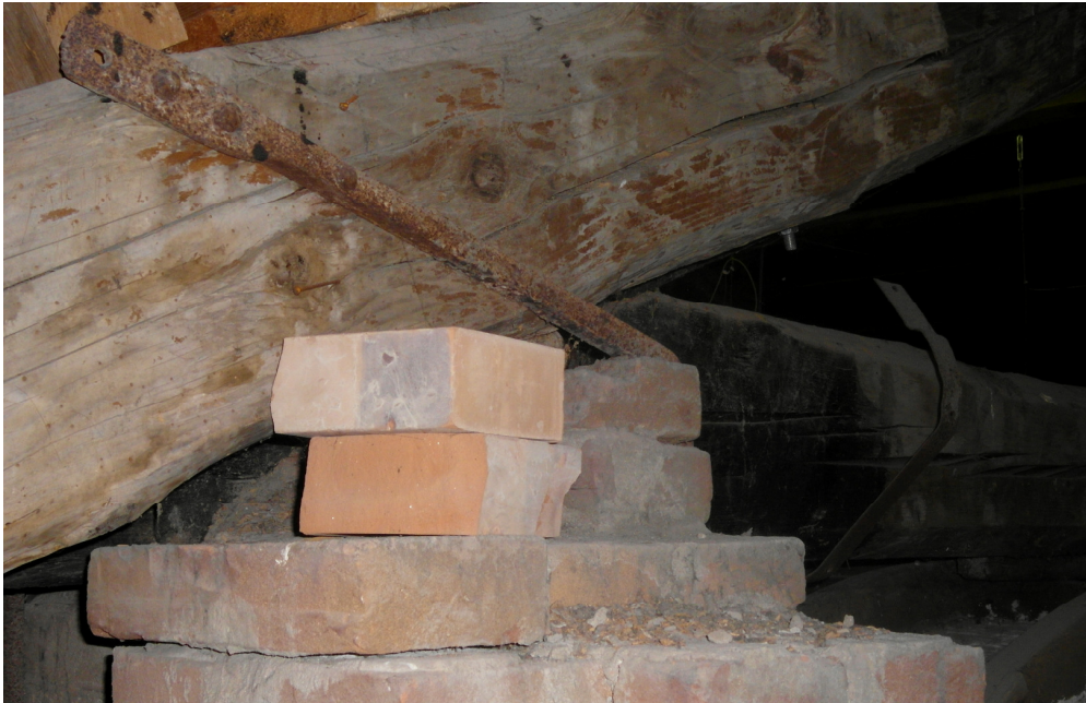
Figura 123 - Particolare della giunzione tra due elementi in legno della copertura
