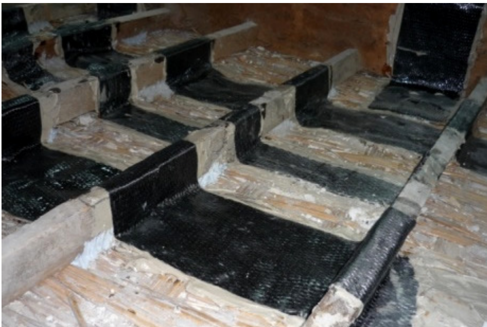
Figura 156 - Utilizzo di fasce di FRP all'estradosso del plafone
