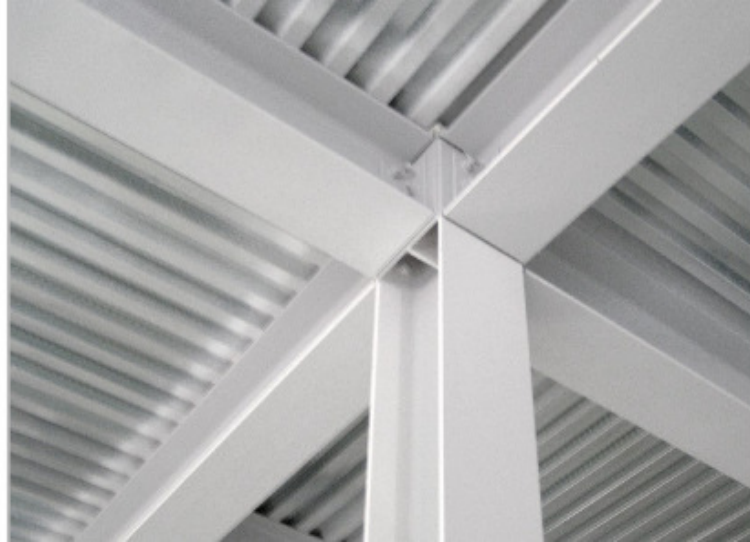
Figura 160 - Vernice intumescente applicata su struttura in acciaio
