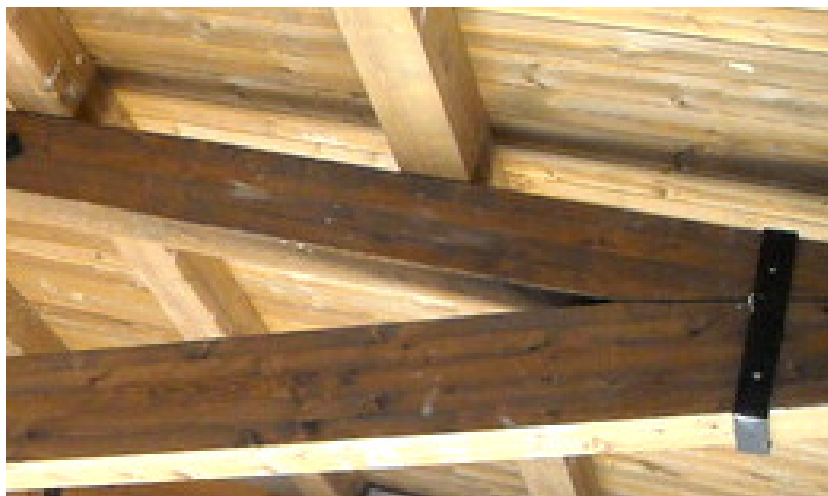
Figura 132 - Esempio collegamento Catena-Puntone tramite piastra in acciaio
