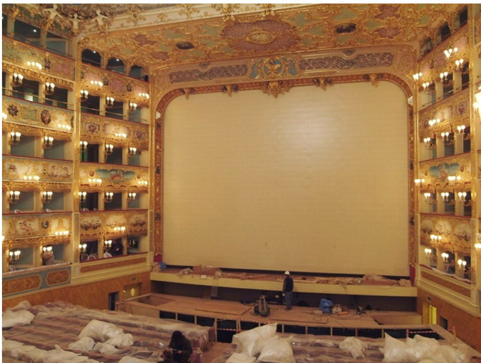
Figura 50 - Sipario di sicurezza tagliafuoco ad anta singola del Teatro "La Fenice" di Venezia
