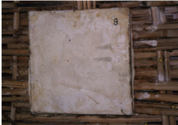
Figura 144 - Particolare dell'intonaco su stuoio di canne
