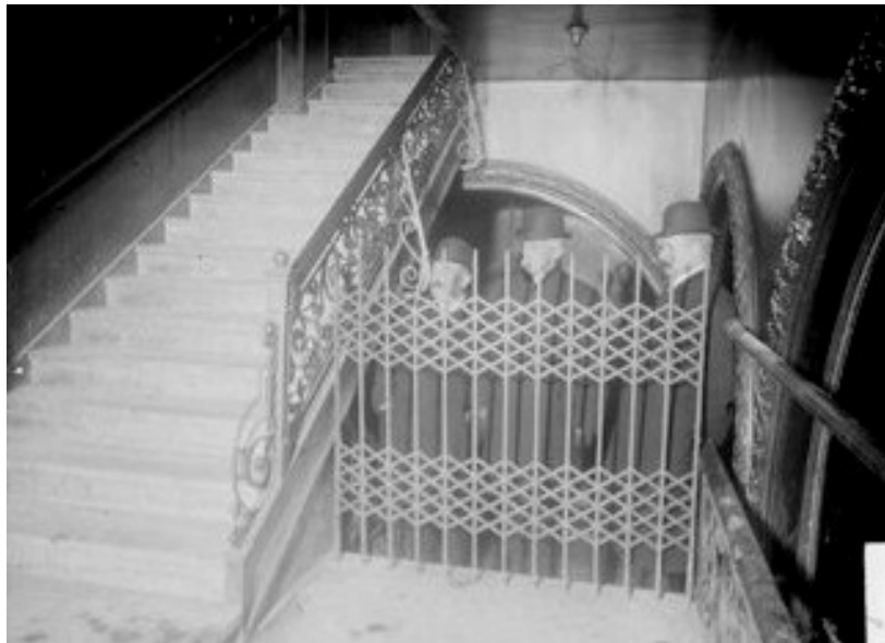
Figura 17 - Una delle uscite chiuse a chiave che impedì la fuga dal teatro
