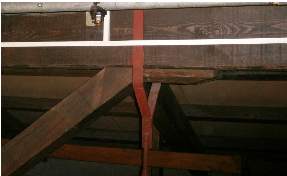
Figura 105 - Parti non rivestibili da trattare con vernice intumescente
