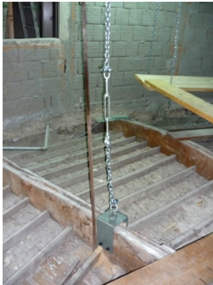
Figura 150 - Sospensione della centina con tirante e profilo in acciaio imbullonato
