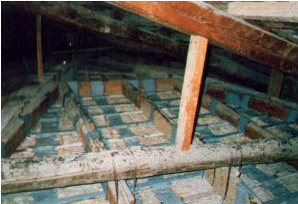
Figura 42 - Estradosso volta in camorcanna
