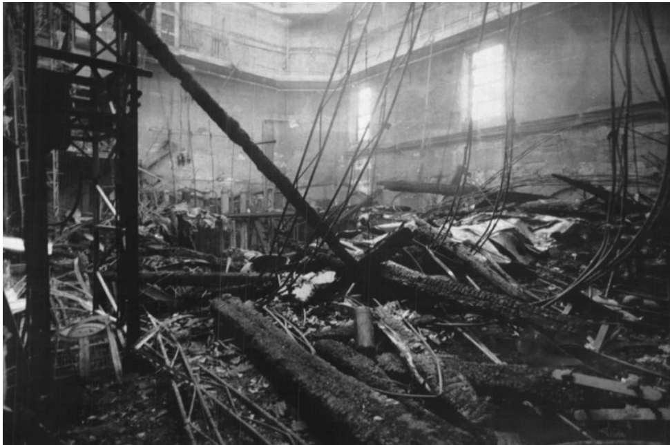
Figura 25 - Resti della copertura crollata durante l'incendio
