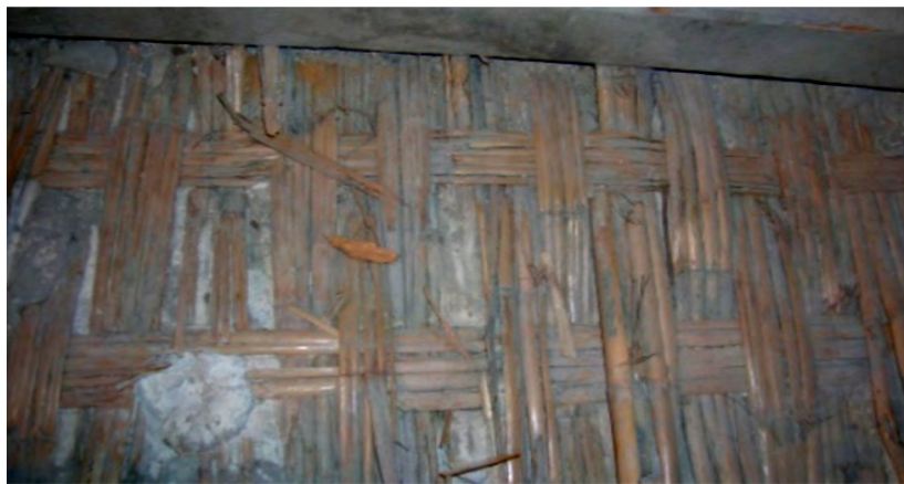
Figura 143 - Stuoiato con fasci di canne ad andamento sinusoidale
