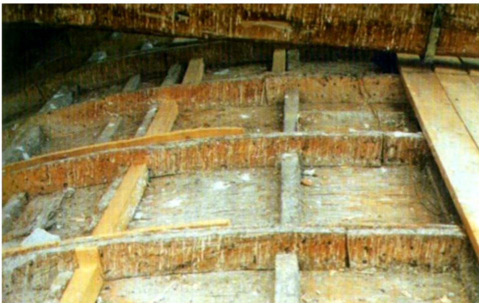
Figura 147 - Consolidamento centine con nuove tavole e nuovi tambocchi
