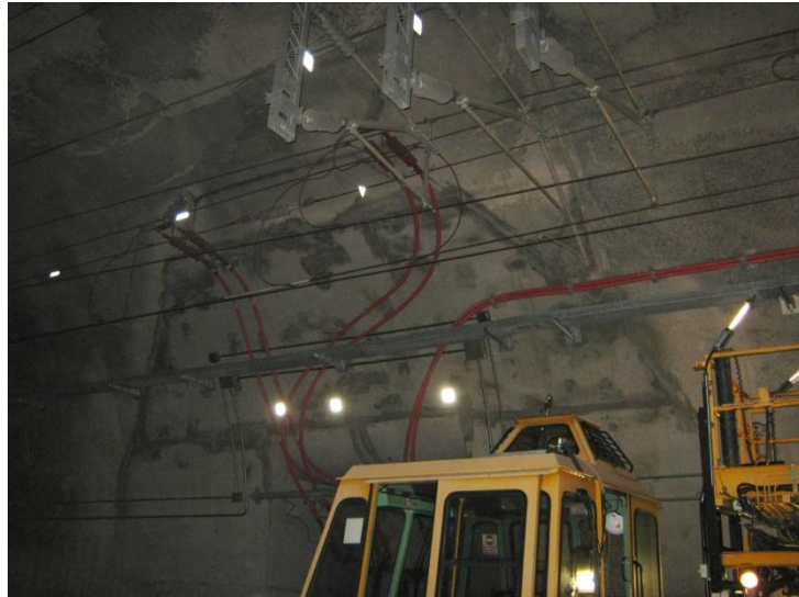
Figura 2.10 – Sezionamento per il cambio fase
