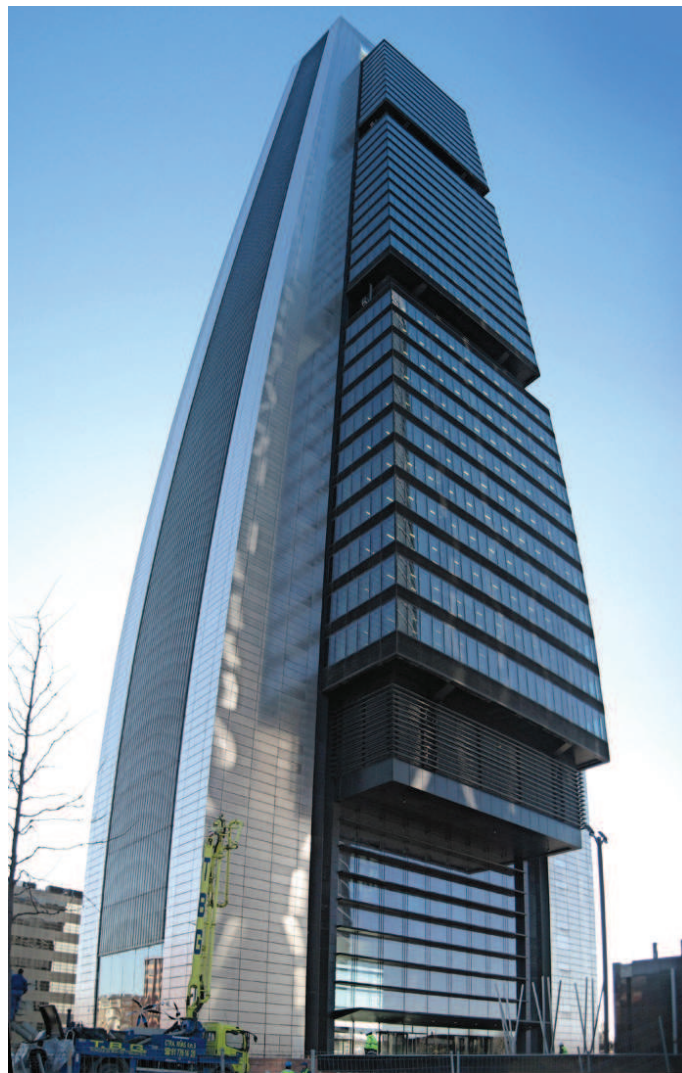
Figura 4.4. Torre Caja Madrid
