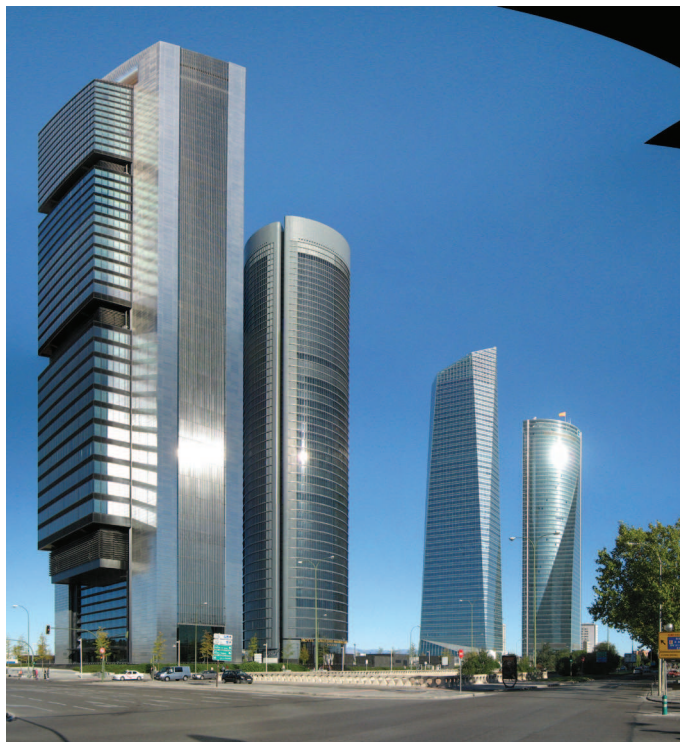
Figura 1.33. Cuatro Torre Business Area (CTBA)
