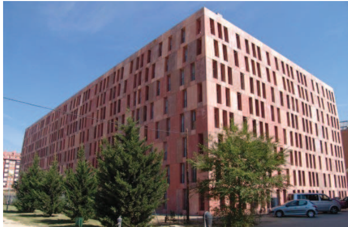
Figura 1.17. Edificio residenziale Villaverde
