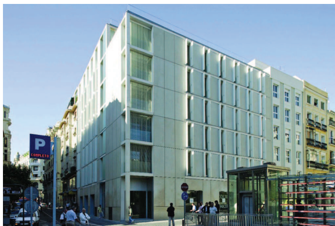
Figura 1.15. Housing presso Calle Clavel
