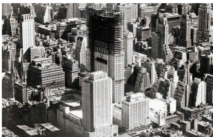
Figura 4.1. Rockefeller Center in costruzione
